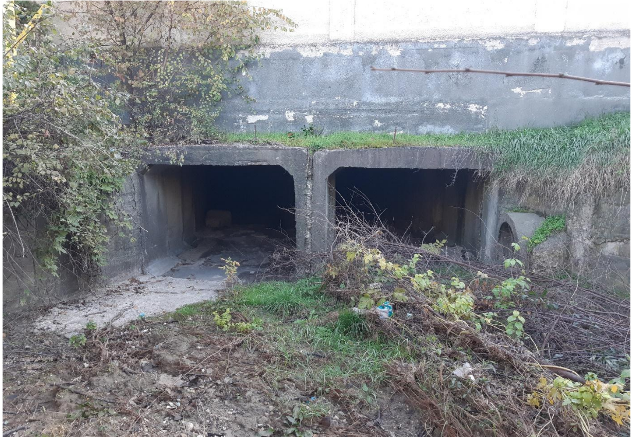
Foto 5 Colector existent 2(2.5x2.0)m. și conductă laterală Ø1.0m) (Существующий коллектор и боковая труба Ø1,0м)
