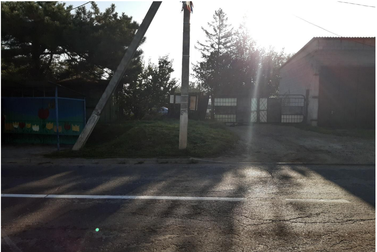
Foto.1 Începutul secțiunii proiectate a traseului G104 PC20+00 km, de la un suport vertical ЛЭП. (Начало проектируемого участка трассы G104 ПК20+00 от вертикальной опоры ЛЭП)
