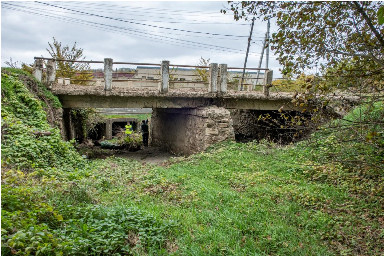
Foto 3 Vedere generală a podului (Общий Вид моста.)
