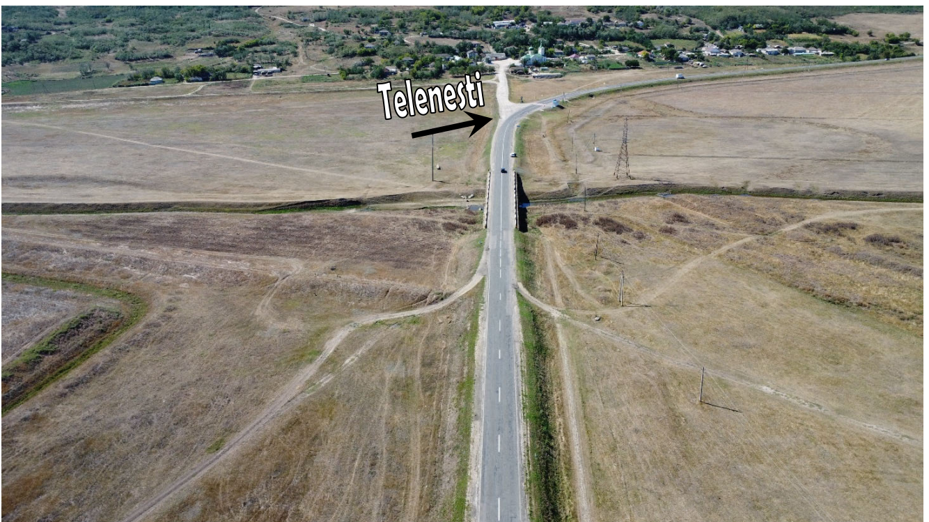
Foto 2. Planul traseului drumului. Podul și rampele de acces. Lipsa scărilor de serviciu, casiuilor de evacuare a apelor și indicatoarelor informaționale și de restricție a vitezei de circulație rutieră.
