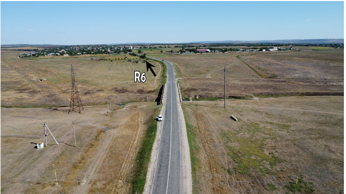
Foto 1. Planul traseului drumului. Podul și rampele de acces. Lipsa scărilor de serviciu, casiuilor de evacuare a apelor și indicatoarelor informaționale și de restricție a vitezei de circulație rutieră.
