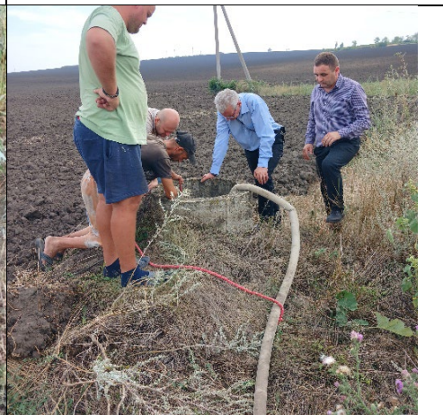
Fig. 28. Evacuare apă din cămin
