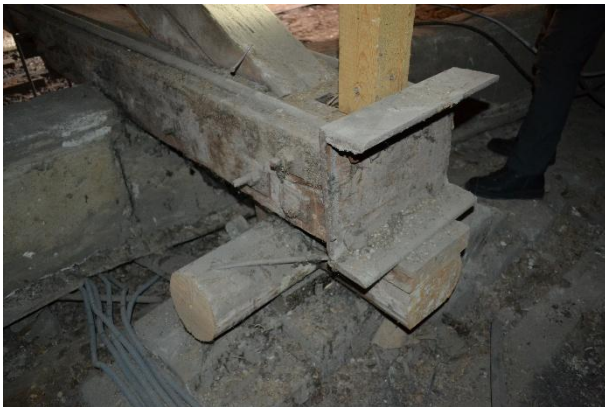
Foto 60-92. Alcătuirea fermelor portante din lemn, consolidate cu elemente de profil metalic:
