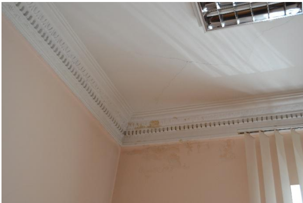
Foto 30-41. Scurgeri identificate pe pereți și tavane de la sectorul acoperișului defect. Elemente structurale interioare.
