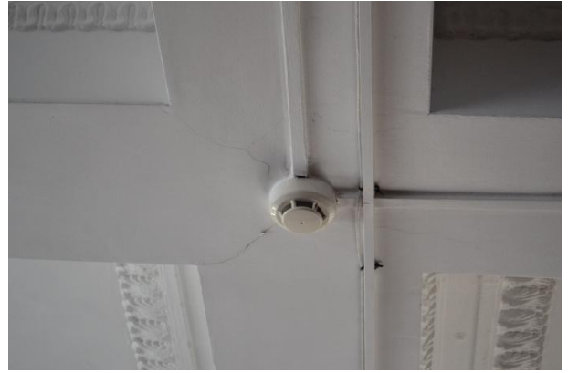
Foto 12-29. Starea tehnică a tavanului suspendat din sala de ședințe. Fisuri și săgeți de încovoiere a grinzilor suspendate de fermele acoperișului.
