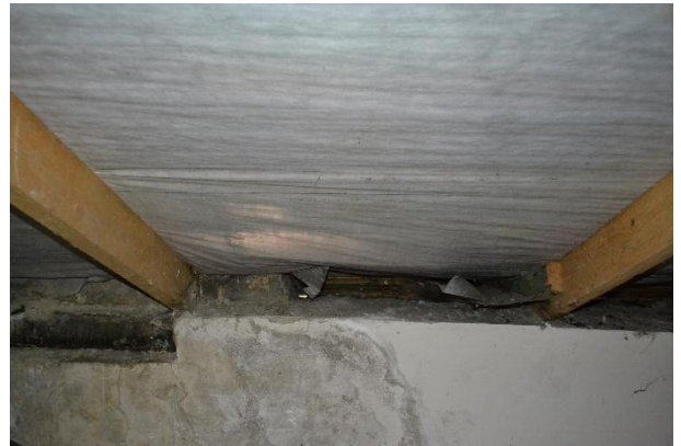
Foto nr.110-120. Degradări de la infiltrări de la ape pluviale între parapet decorativ și învelitoarea acoperișului.
