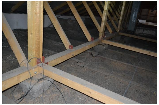
Foto 60-92. Alcătuirea fermelor portante din lemn, consolidate cu elemente de profil metalic:
