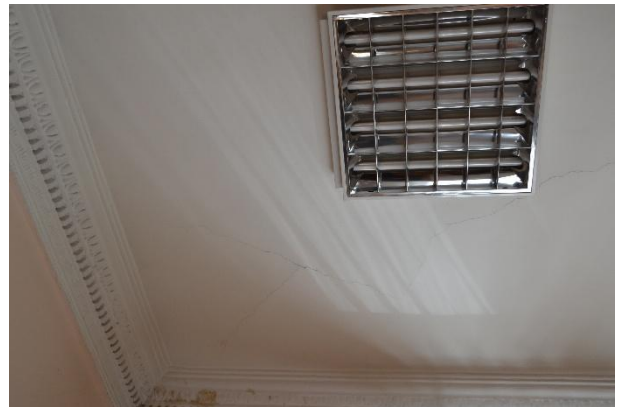
Foto 30-41. Scurgeri identificate pe pereți și tavane de la sectorul acoperișului defect. Elemente structurale interioare.
