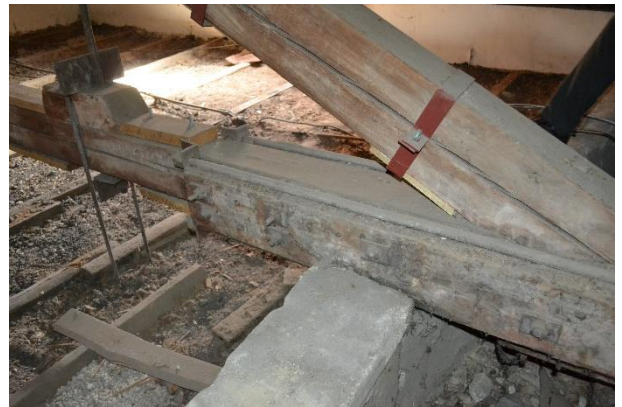
Foto 60-92. Alcătuirea fermelor portante din lemn, consolidate cu elemente de profil metalic:
