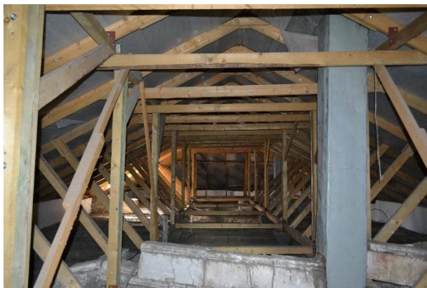
Foto 42-59. Starea tehnică a elementelor structurale ale acoperișului reconstruit și planșeului examinat.
