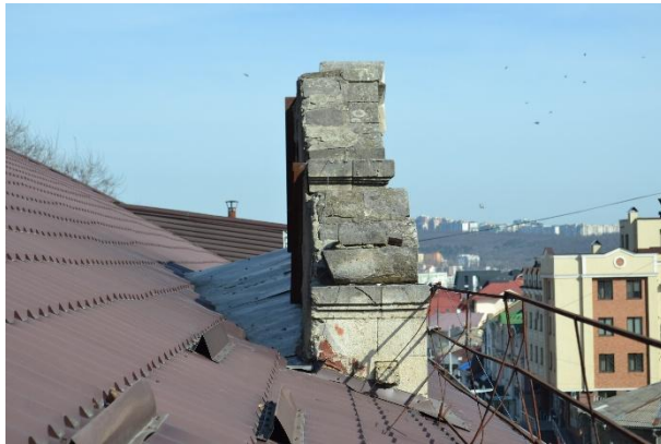
Foto nr.110-120. Degradări de la infiltrări de la ape pluviale între parapet decorativ și învelitoarea acoperișului.
