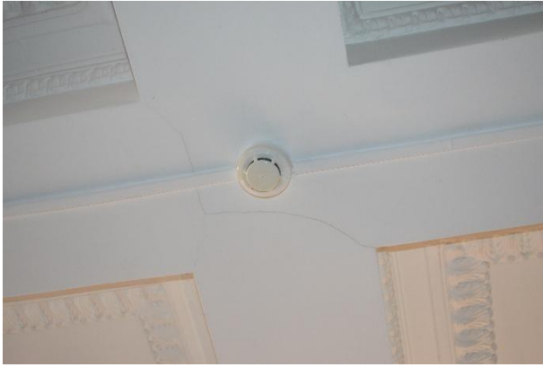
Foto 12-29. Starea tehnică a tavanului suspendat din sala de ședințe. Fisuri și săgeți de încovoiere a grinzilor suspendate de fermele acoperișului.
