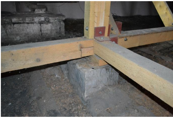
Foto 60-92. Alcătuirea fermelor portante din lemn, consolidate cu elemente de profil metalic:
