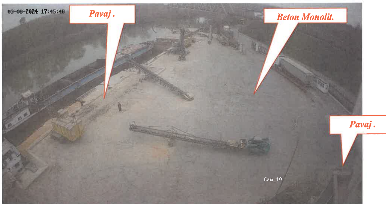
Foto.1. Situatia existanta pe platforma
