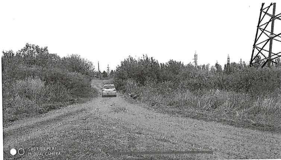
Foto.3. Situatia existanta drum de acces la PC8+15
