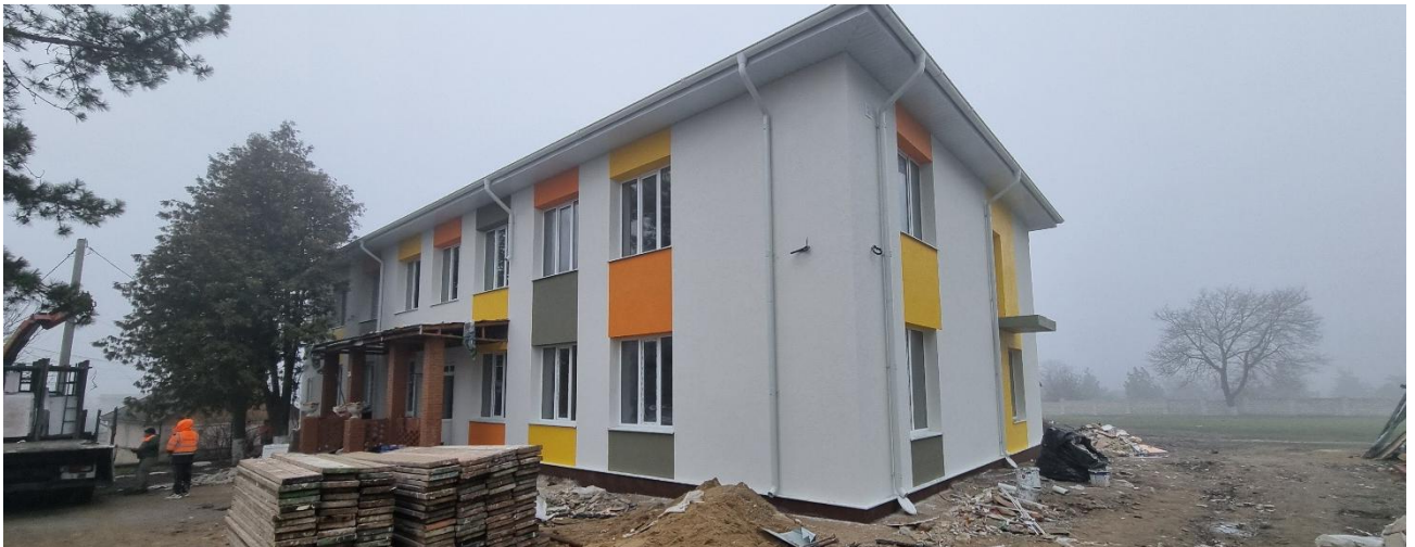
Figura 6. Vedere a clădirii Bloc Clasele Primare
