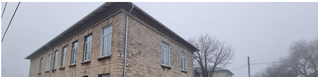
Figură 13. Vedere a acoperișului
