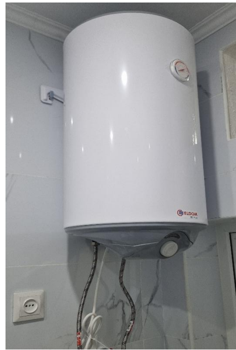
Figura 21. Vedere boilere pentru prepararea apei calde menajere
