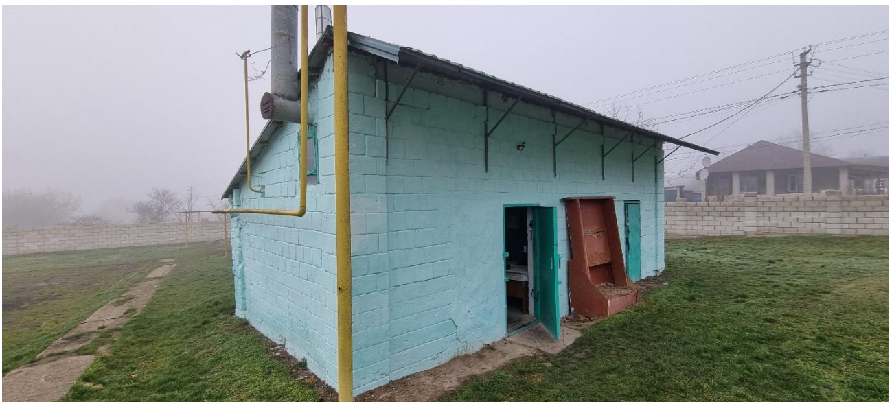
Figura 19. Vedere a sistemului cazangeriei
