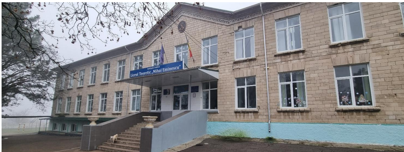
Figura 1. Vedere generală a clădirii
