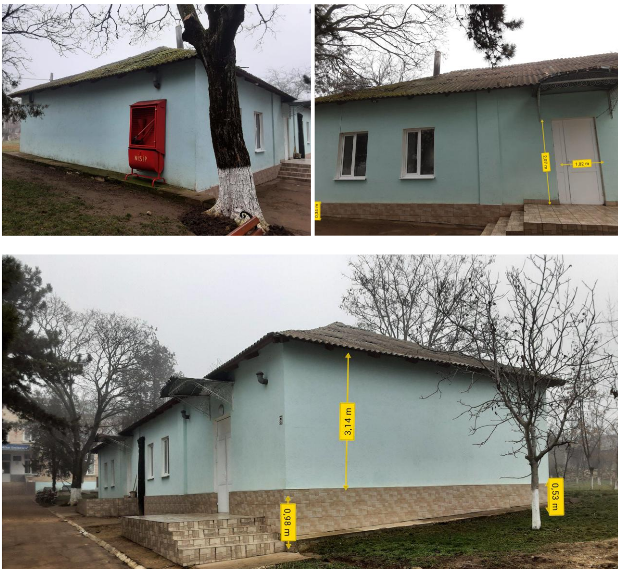
Figură 7. Vedere a clădirii Bloc Cantină
