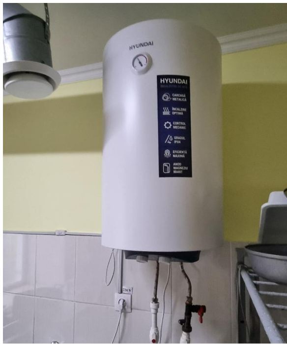
Figura 21. Vedere boilere pentru prepararea apei calde menajere
