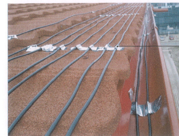
Analogie amplasare cablu de degivrare
