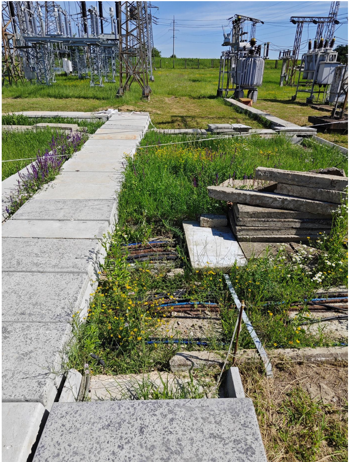
Vederea din punctul D spre punctul C (canalele vechi în pct. D din poza sunt demontate)
