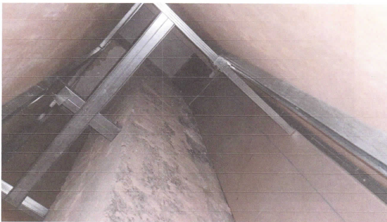
Foto nr. 165; 166. Deschideri efectuate la demisol în zona amplasării coloanelor marginale (pe axa "B") ale planșeului intermediar executat în anul 1998, care sunt ancorate în grinzile structurale transversale de la nivelul planșeului demisolului (fără a fi continuate până la fundații).
