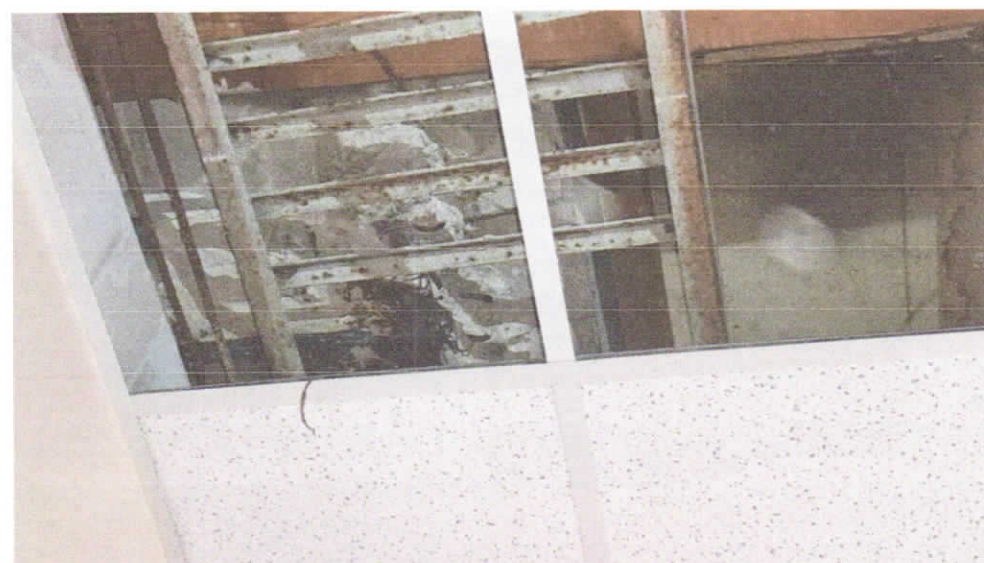
Foto nr. 54; 55; 56. Scara interioară de acces între demisol și parter demontată iar golul în planșeu căptușit prin execuția unui planșeu cu grinzi metalice și podină din PFL pe astereală de cherestea.
