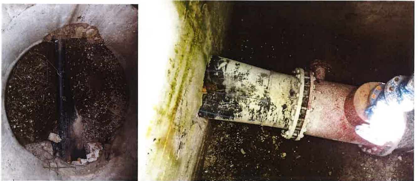
Figura 3.24. Starea conductei de apă în cămine (SP-2 până la stația de tratare)
