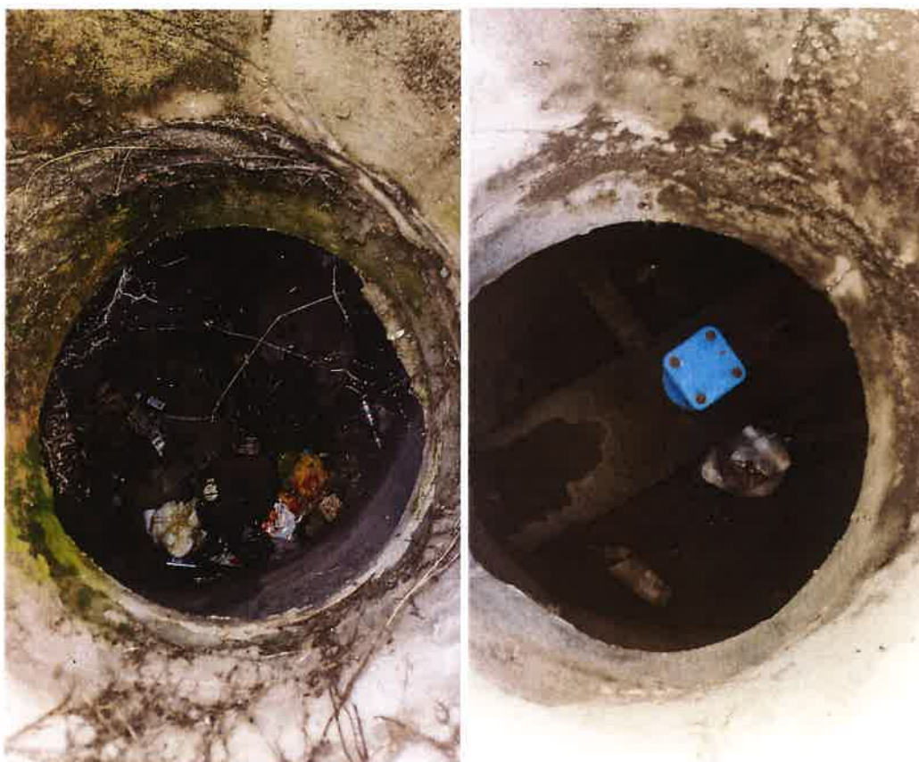
Figura 2.7. Cămin de vizitare existent pe segmentul SP-5 – SP-2
