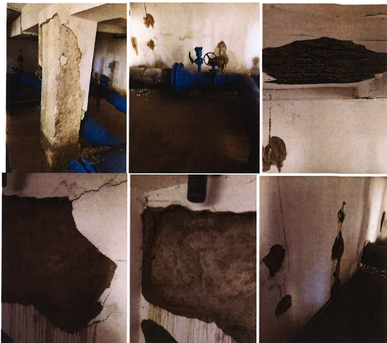
Figura 3.15. Starea actuală a stației de pompare din încăperea pompelor (SP-2)
