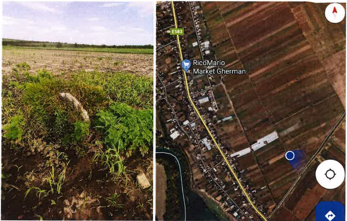
Figura 3.11. Presupus cămin deteriorat de mașinile agricole
