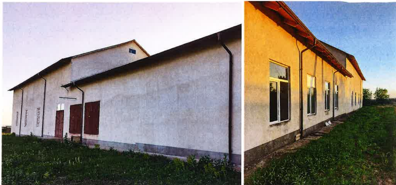
Figura 2.10. Stația de pompare SP-2. Vedere din exterior
