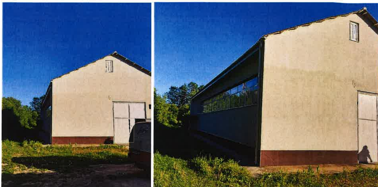
Figura 2.5. Stația de pompare SP-5. Vedere din exterior
