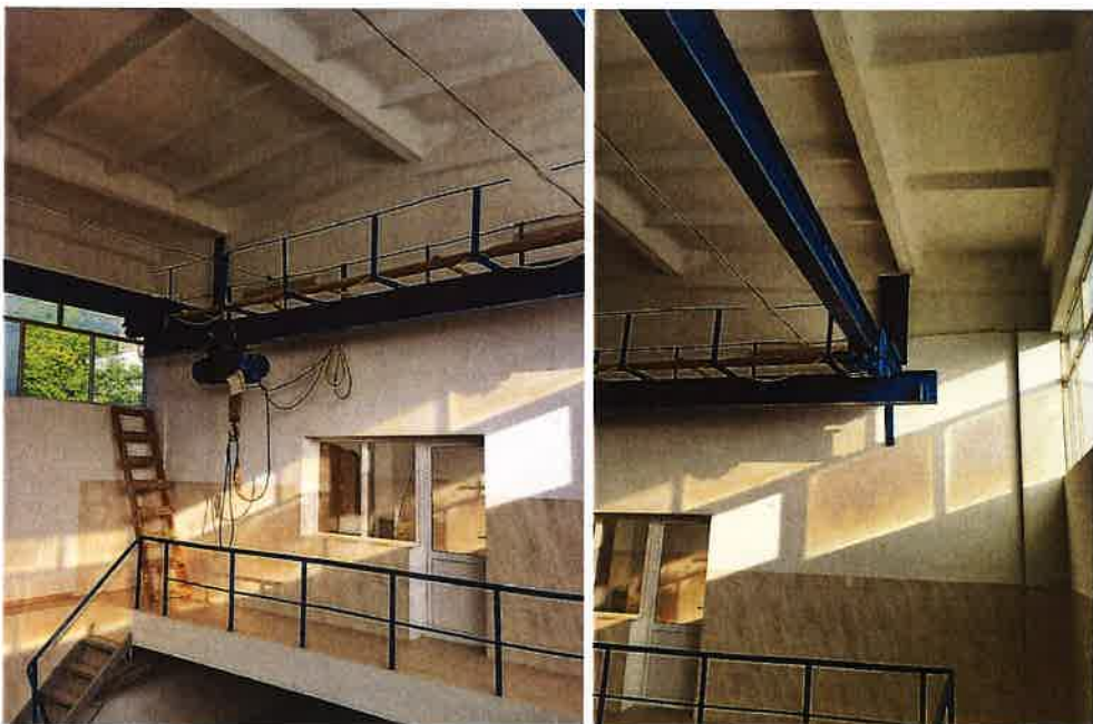
Figura 3.6. Sistem de ridicare a pompelor (palan) (SP-5)
