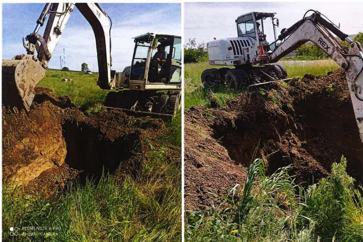
Figura 3.22. Lucrări de excavare
