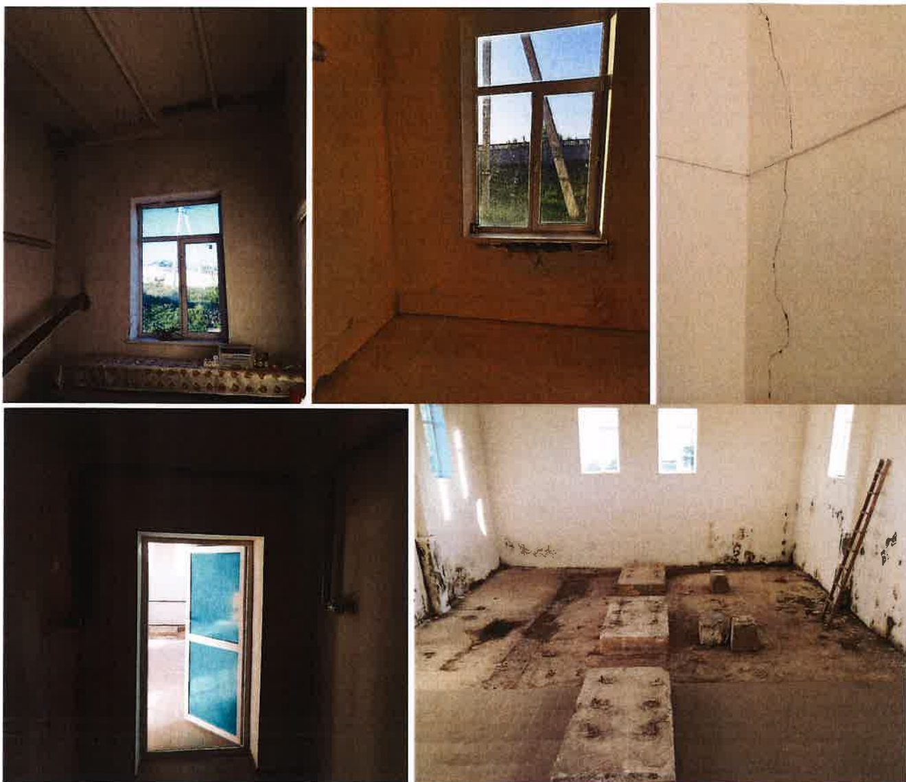
Figura 3.14. Starea actuală a stației de pompare (SP-2)
