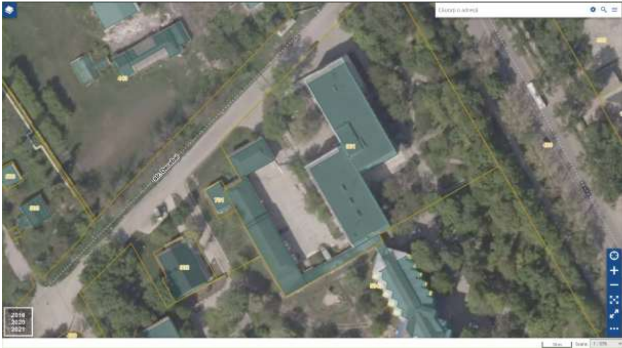
Figura 1. Vederea instituției pe centru pe site-ul geoportal.md
