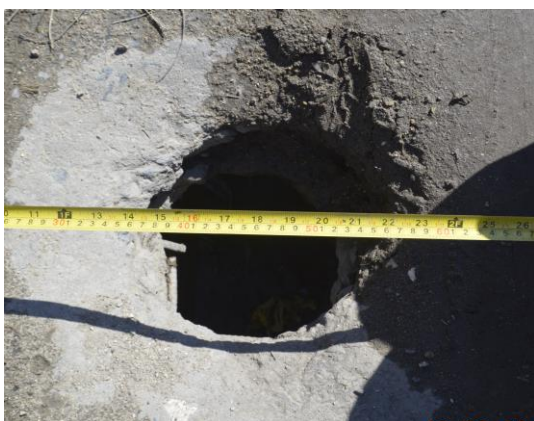
Fig.3.6.5 Starea tehnică existentă a gurilor de captare și evacuare a apelor de pe carosabilul podului. Guri de scurgere -1,2,3,4 conform amenajării plane.
