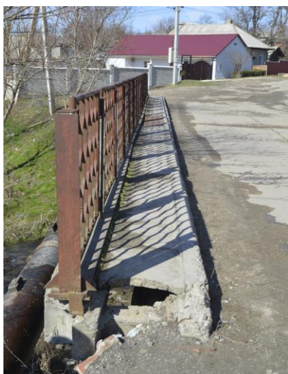
Fig.3.6.6 Starea tehnică și amenajarea existentă a trotuarelor. Degradarea plăcii de trotuar și a racordării trotuar-rampă de acces.
