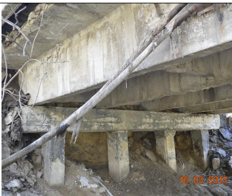
Fig.3.3.3 Afuieri și spălarea sferutilor de con și a racordării culeelor C1 și C2
