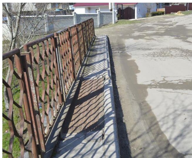
Fig.3.6.6 Starea tehnică și amenajarea existentă a trotuarelor. Degradarea plăcii de trotuar și a racordării trotuar-rampă de acces.
