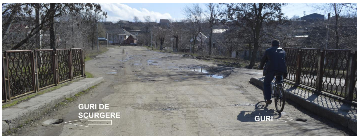
Fig.3.6.4 Vedere de situație a accesului pe pod din str. Griviței. Guri de scurgere.
