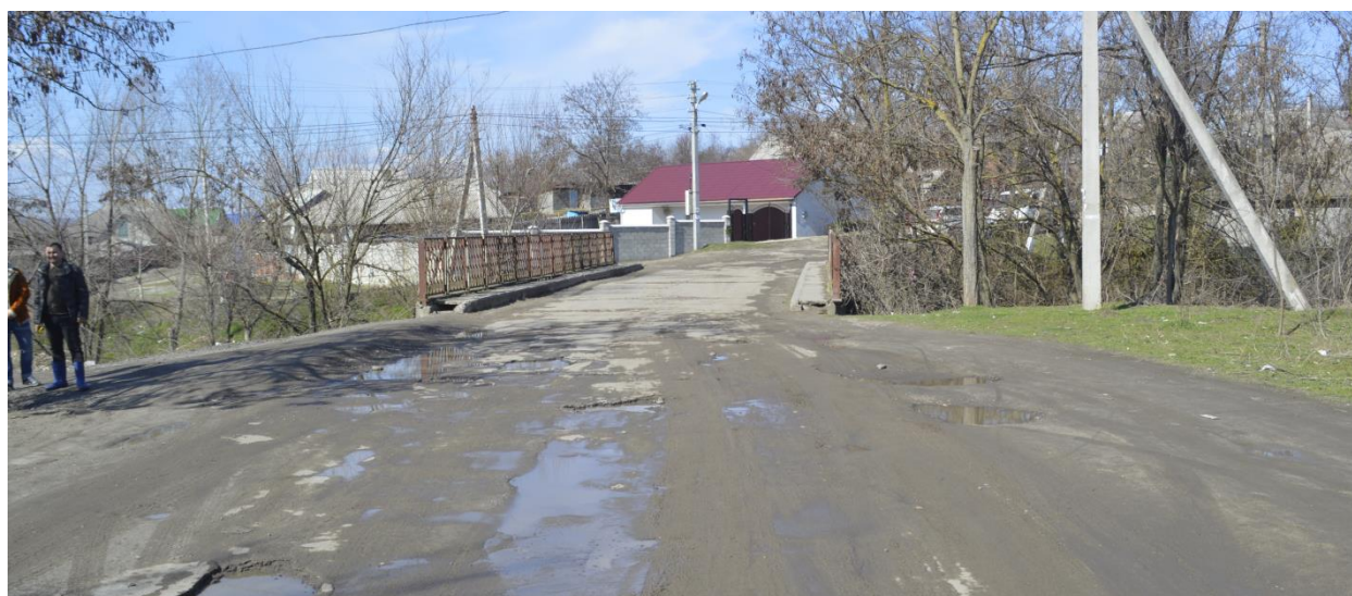
Fig.3.6.2 Vedere de situație a accesului pe pod din str. Griviței.
