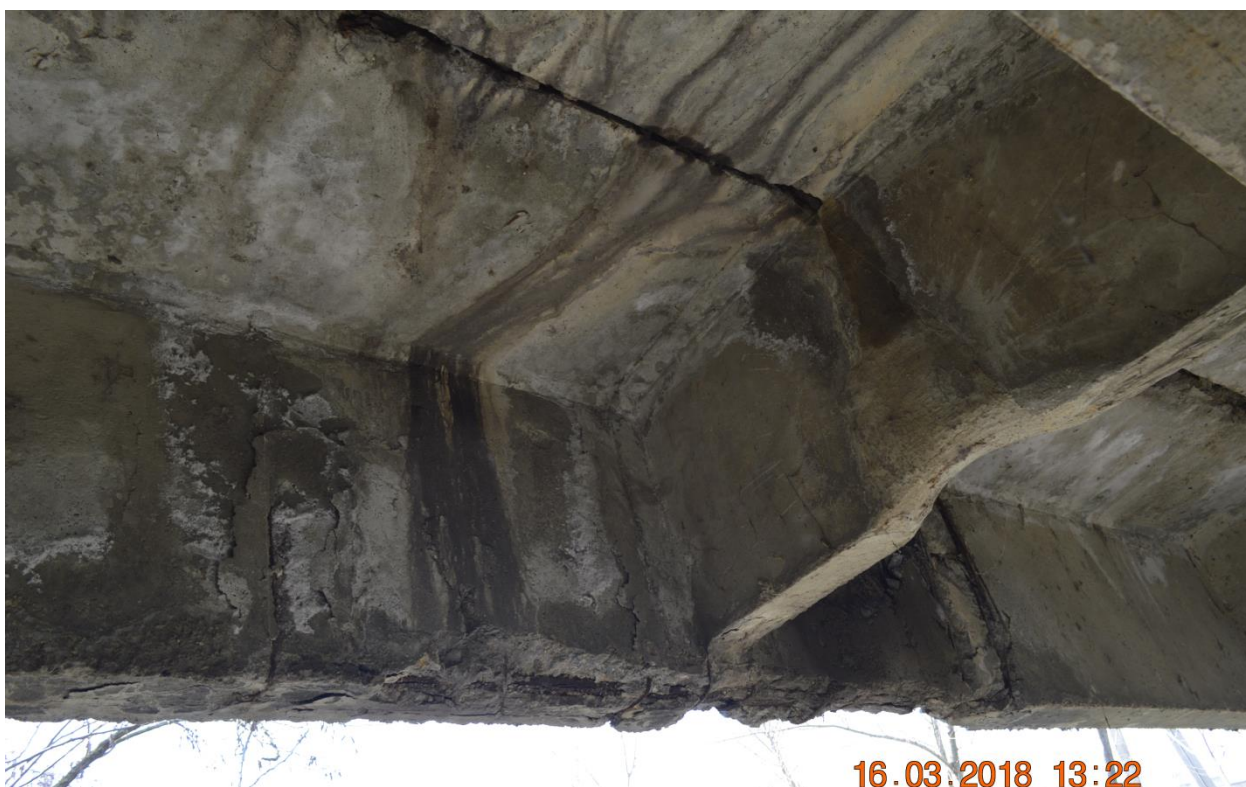
Fig. 3.5.13 Starea tehnică a suprastructurii deschiderii Nr.2. Grinda nr.10.
