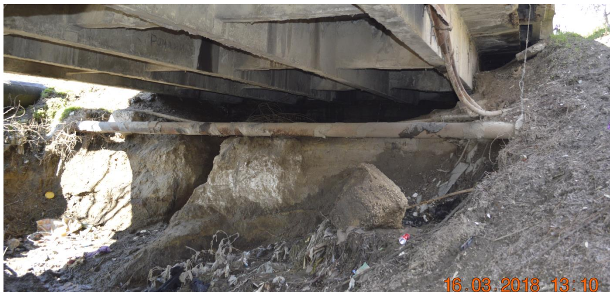
Fig.3.4.1.1 Vedere culee C1, situație existentă.
