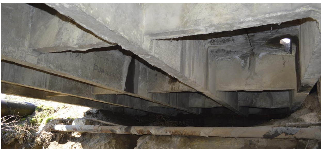
Fig. 3.5.6 Starea tehnică a suprastructurii deschiderii Nr.1. Grinzile nr.1-nr.5, degradare rosturi, etc, contasăgeata, lipsa gurilor de captare și scurgere a apelor.
