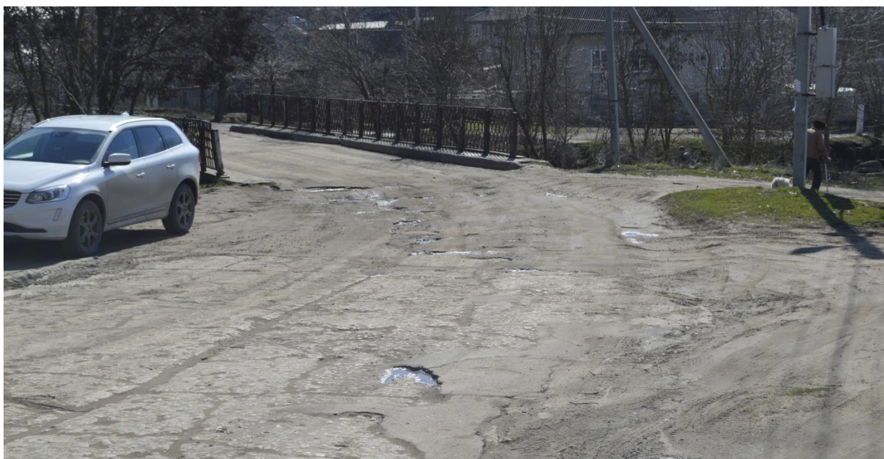
Fig.3.6.1 Vedere de situație a accesului de pe pod din str. Nufărul Alb.
