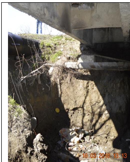
Fig.3.3.3 Afuieri și spălarea sferutilor de con și a racordării culeelor C1 și C2
