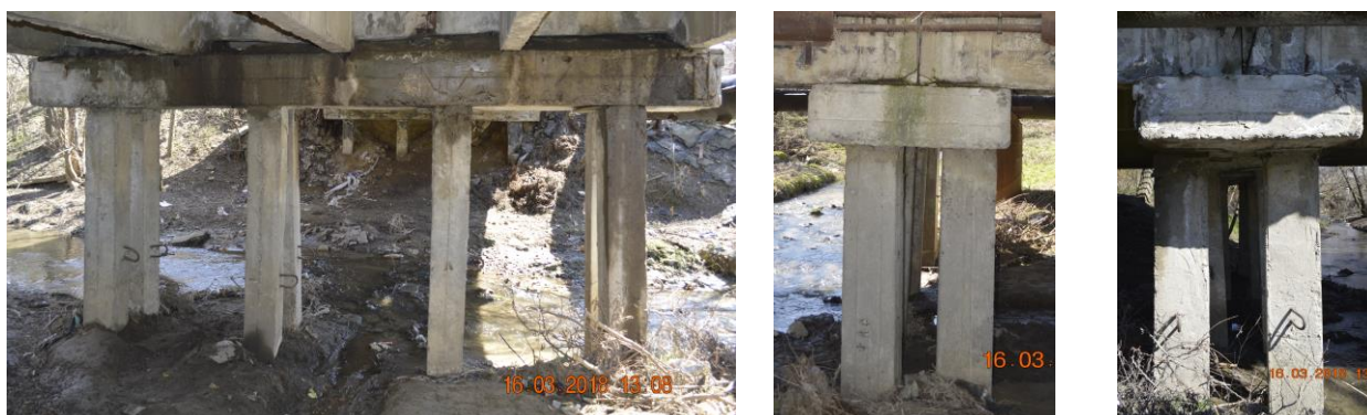
Fig. 3.4.3.1 Vedere existentă a pilei podului P1. Vedere elevație. Vedere pila amonte. Vedere pilă aval.
