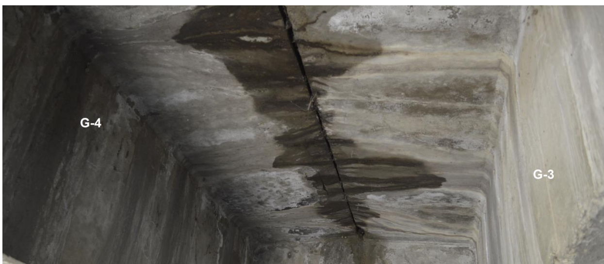
Fig. 3.5.6 Starea tehnică a suprastructurii deschiderii Nr.1. Grinzile nr.1-nr.5, degradare rosturi, etc, contasăgeata, lipsa gurilor de captare și scurgere a apelor.
