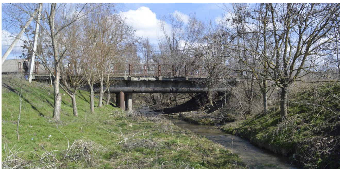
Fig.3.3.1 Vedere din aval a albiei pod str. Griviţei.
