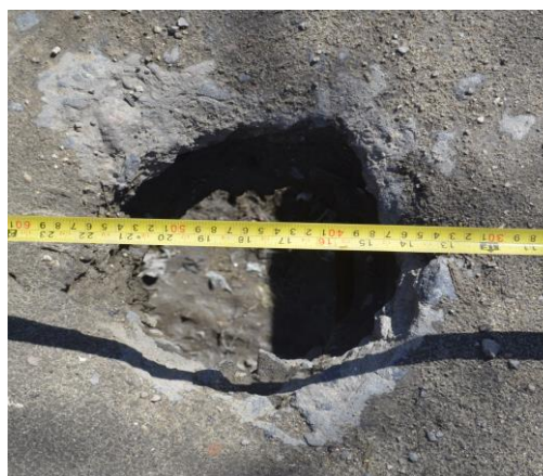
Fig.3.6.5 Starea tehnică existentă a gurilor de captare și evacuare a apelor de pe carosabilul podului. Guri de scurgere -1,2,3,4 conform amenajării plane.
