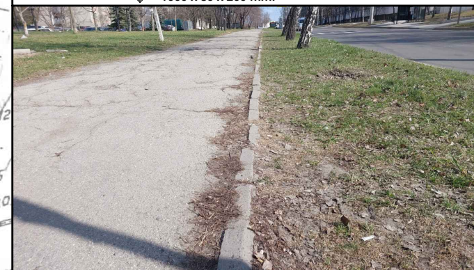
2 Bordura existenta din beton demontata 1000 x 80 x 200 mm.
