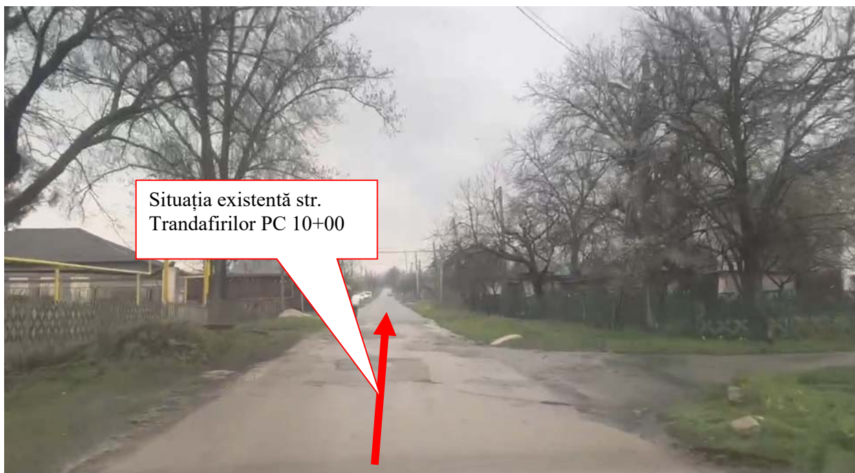
Fig. 1.2.20 Situație existentă str. Trandafirilor PC 10+00
