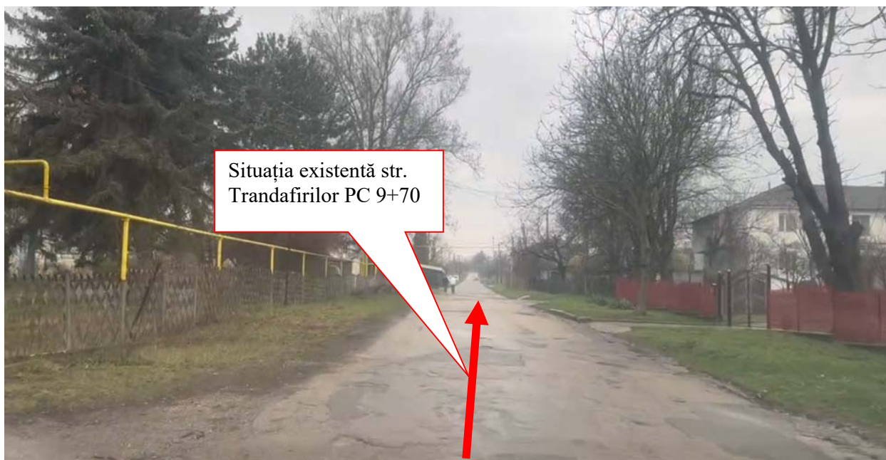
Fig. 1.2.19 Situație existentă str. Trandafirilor PC 9+70
