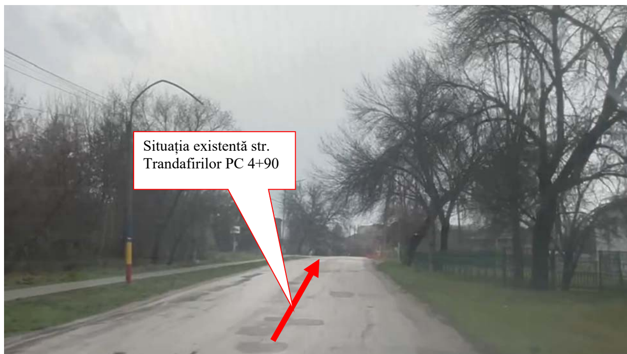
Fig. 1.2.10 Situație existentă str. Trandafirilor PC 4+90
