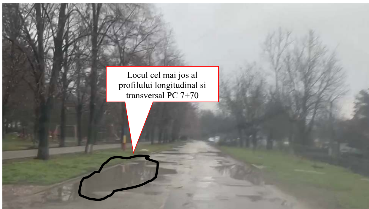
Fig. 1.2.15 Situație existentă str. Trandafirilor PC 7+70
