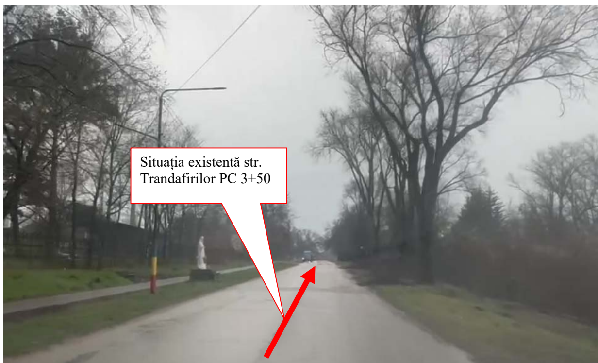
Fig. 1.2.8 Situație existentă str. Trandafirilor PC 3+50
