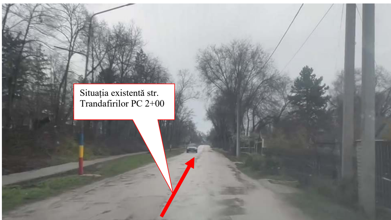
Fig. 1.2.6 Situație existentă str. Trandafirilor PC 2+00
