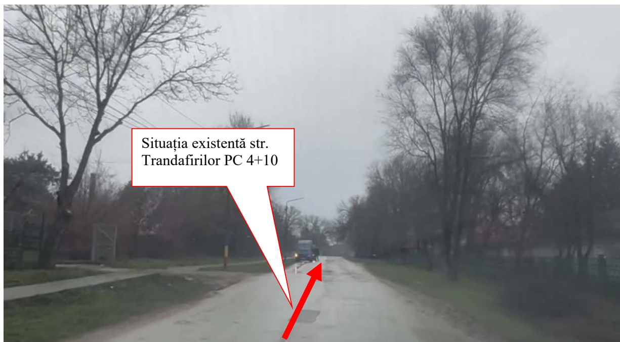
Fig. 1.2.9 Situație existentă str. Trandafirilor PC 4+10
