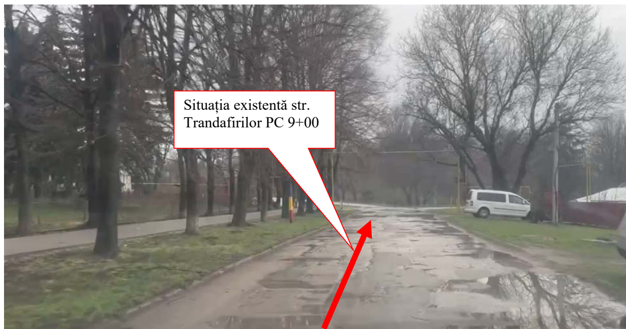
Fig. 1.2.17 Situație existentă str. Trandafirilor PC 9+00
