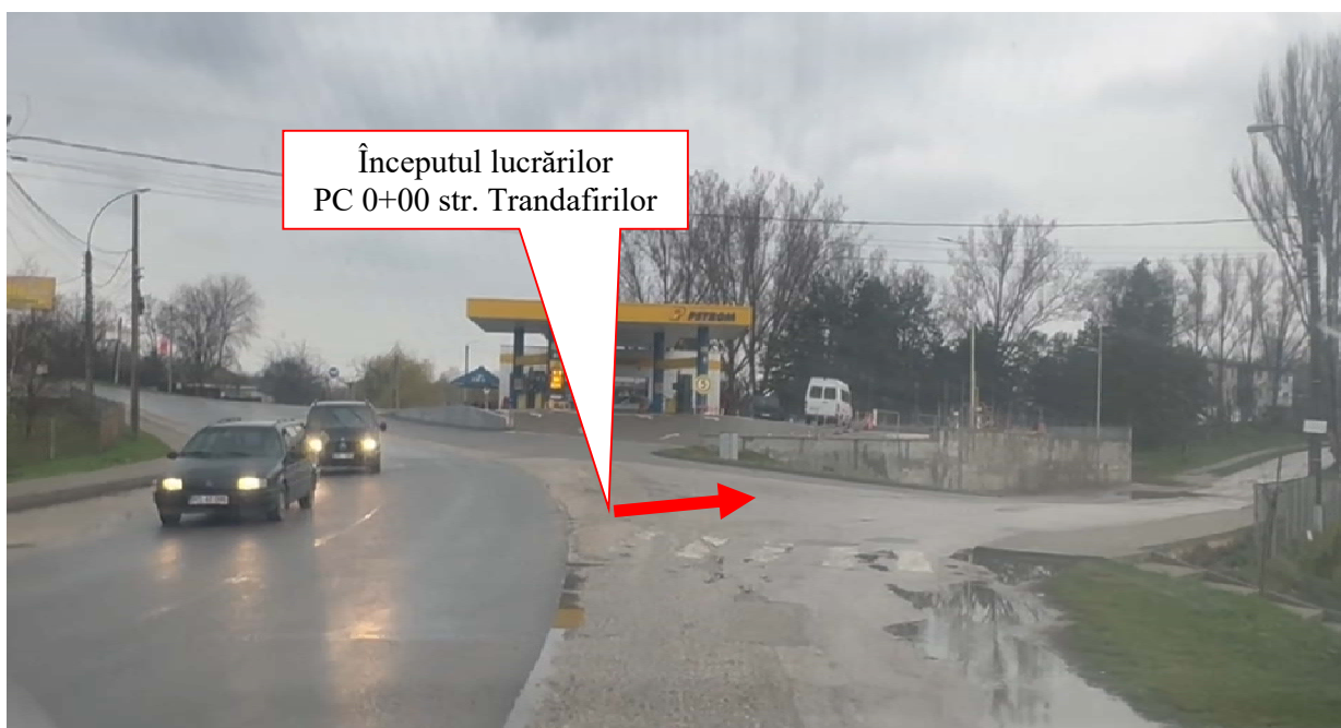
Fig. 1.2 Începutul Lucrărilor PC 0+00 (str. Trandafirilor)
