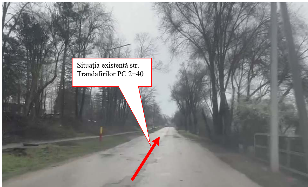
Fig. 1.2.7 Situație existentă str. Trandafirilor PC 2+40
