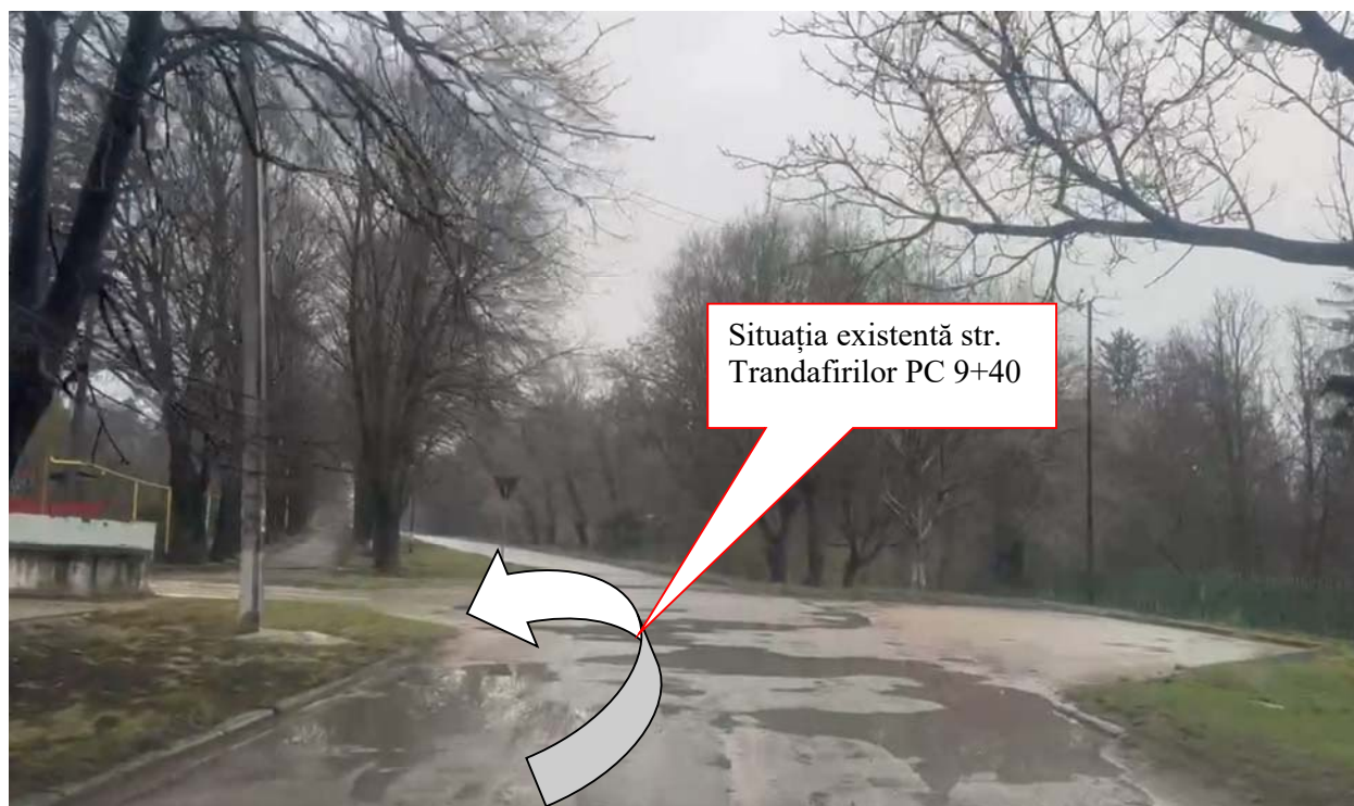
Fig. 1.2.18 Situație existentă str. Trandafirilor PC 9+40
