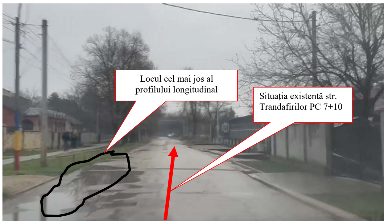
Fig. 1.2.13 Situație existentă str. Trandafirilor PC 7+10
