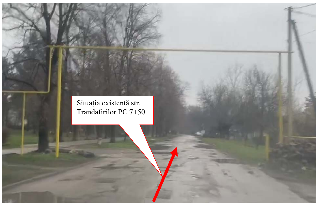
Fig. 1.2.14 Situație existentă str. Trandafirilor PC 7+50
