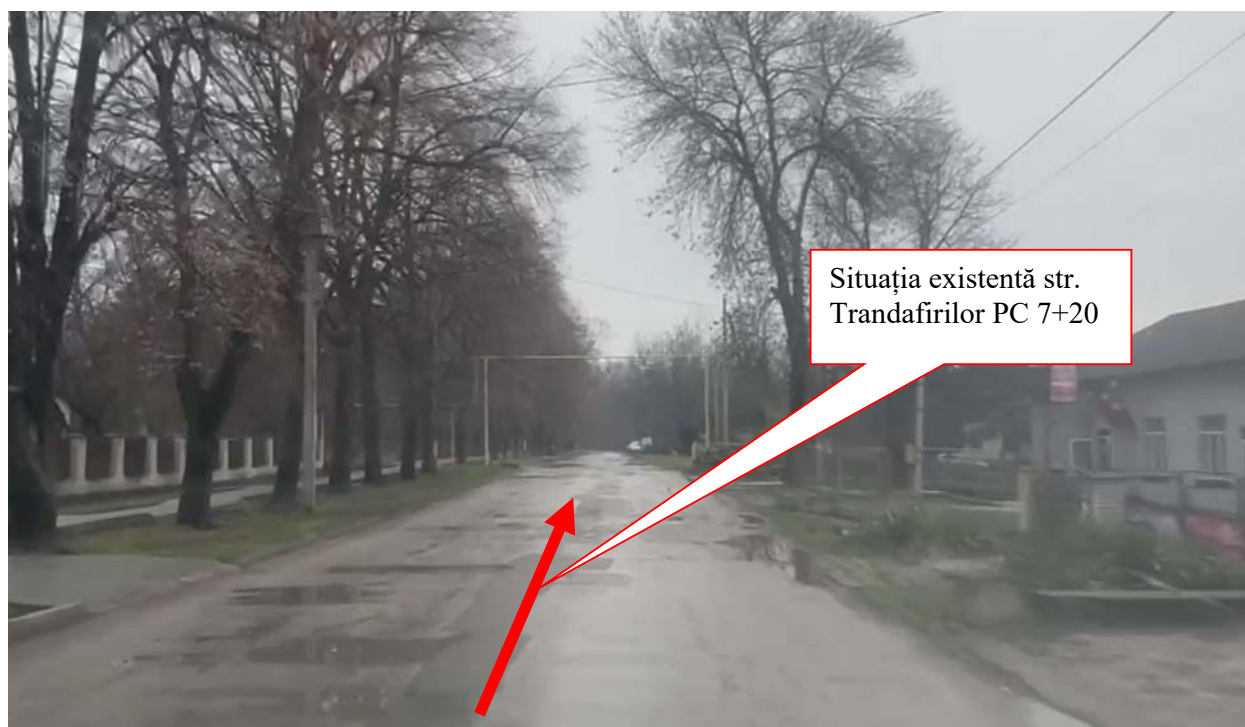
Fig. 1.2.14 Situație existentă str. Trandafirilor PC 7+20
