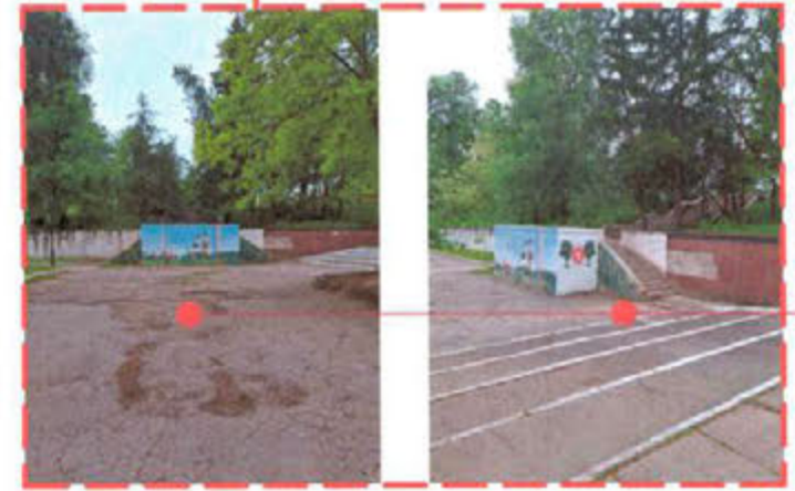
Suprafata asfaltata pentru demolare
