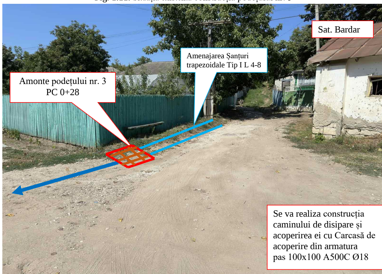
Fig. 1.12. Situația existentă construcția podețului nr. 3
