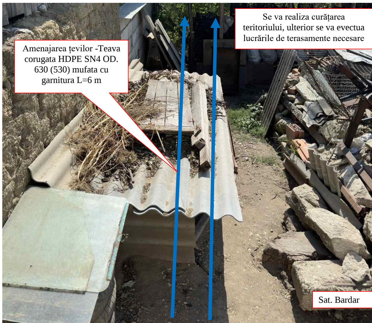
Fig. 1.9 Situația existentă construcția podețului nr.2
