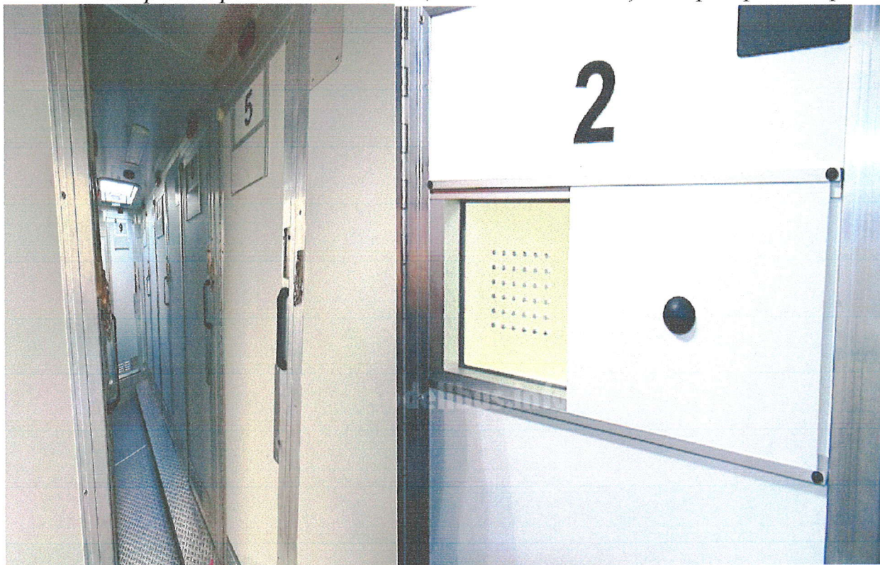
Aspectul culoarului dintre celule, ușile celulelor și oberlihtul celulei
