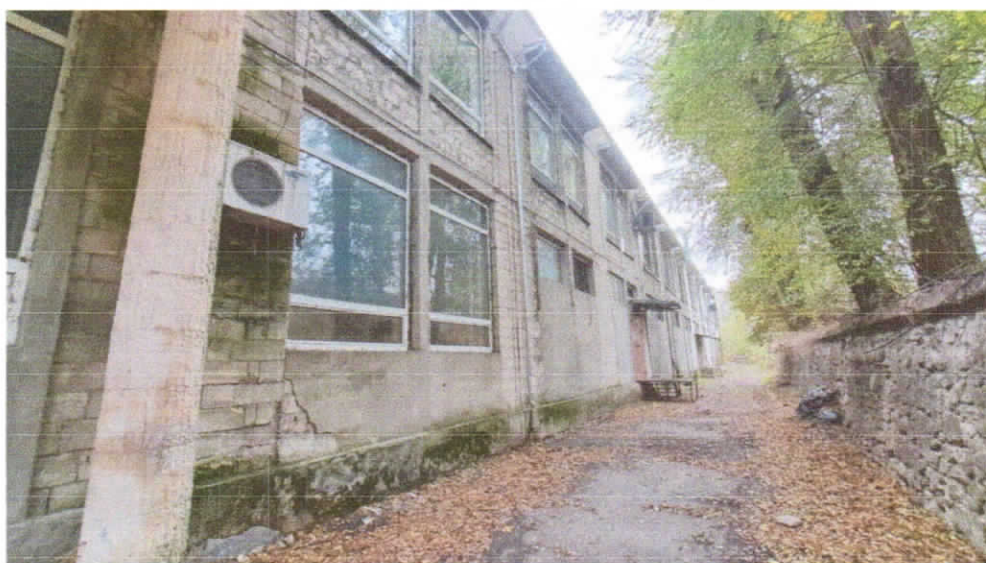
Foto nr. 3. Fațada din partea de Nord-Est (vedere generală).
