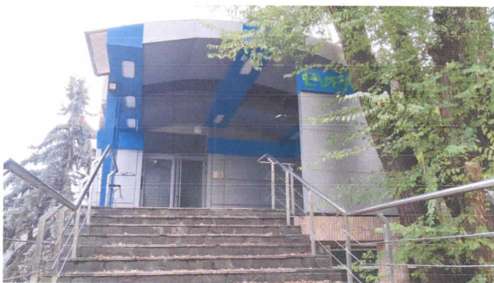
Foto nr. 14; 15; 16. Construcția pasarelei de acces la etajul clădirii (vederi generale).
