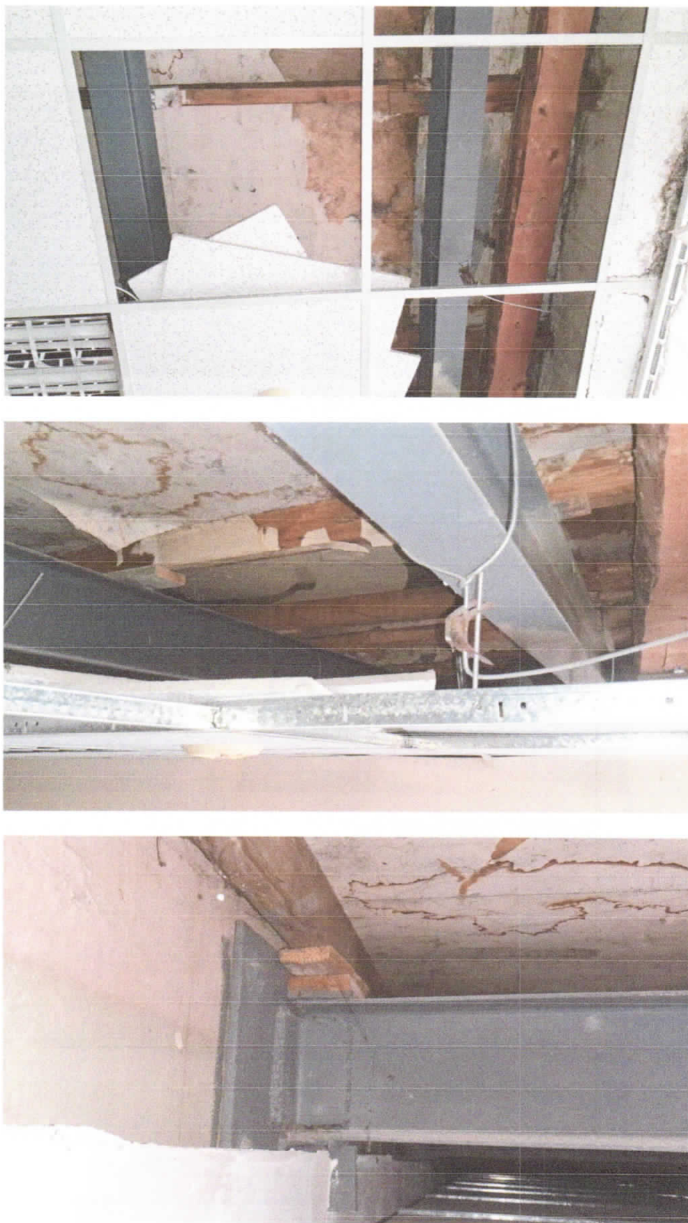
Foto nr. 51; 52; 53. Scara interioară de acces între demisol și parter demontată iar golul în planșeu căptușit prin execuția unui planșeu cu grinzi metalice și podină din PFL pe astereală de cherestea.
