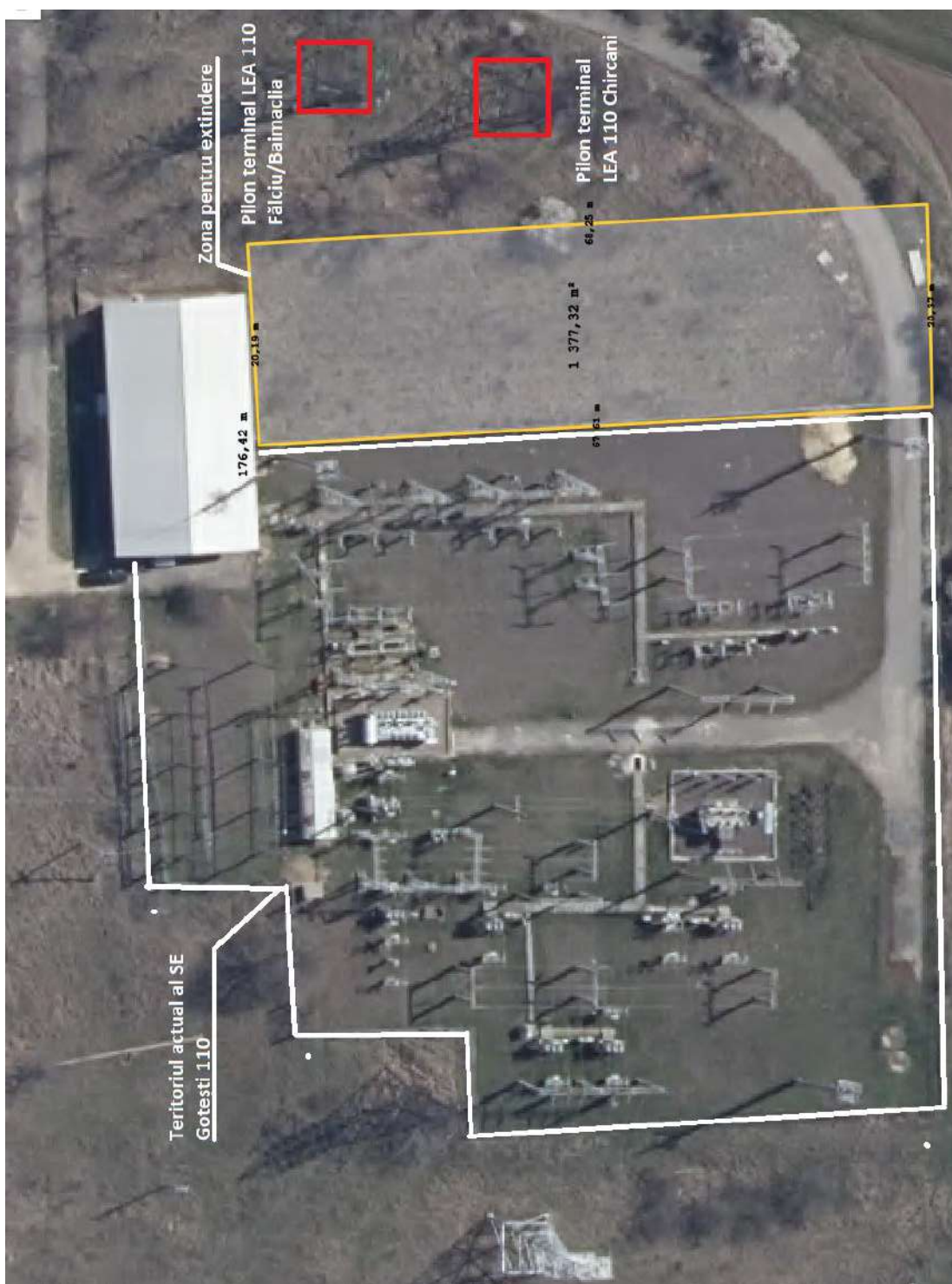
SE Gotești 110/35/10 kV vederea generală
