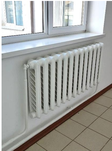
Figura 16. Sistemul interior de distribuție a energiei termice.
