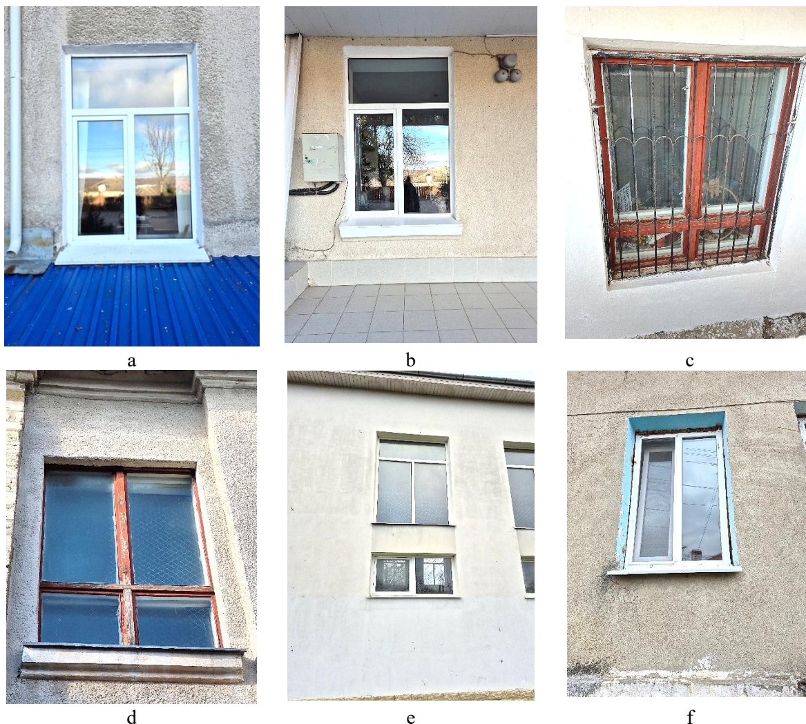
Figura 13. Vedere a ferestrelor clădirii
