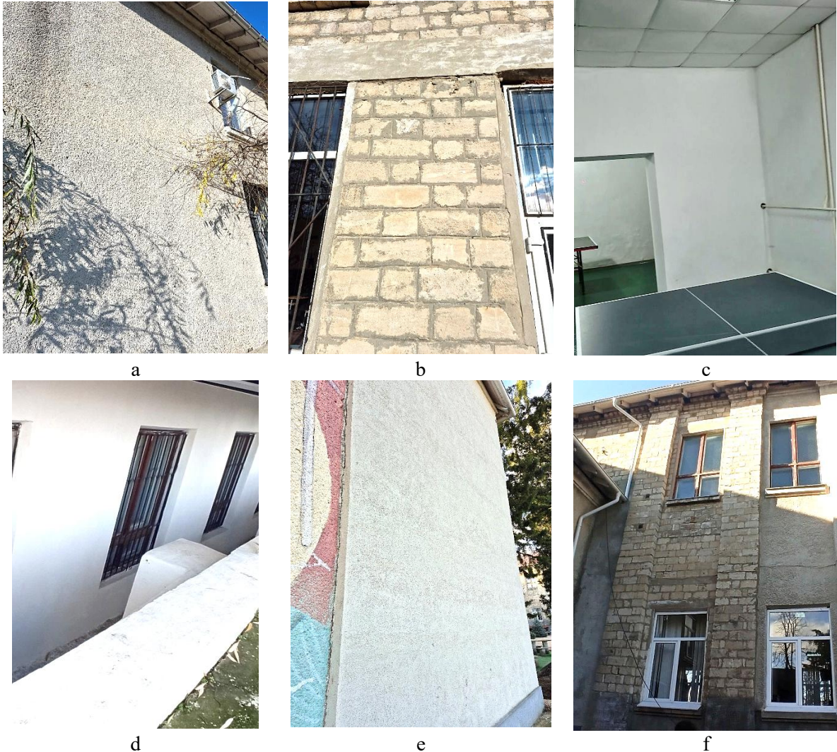
Figura 10. Vedere a pereților
