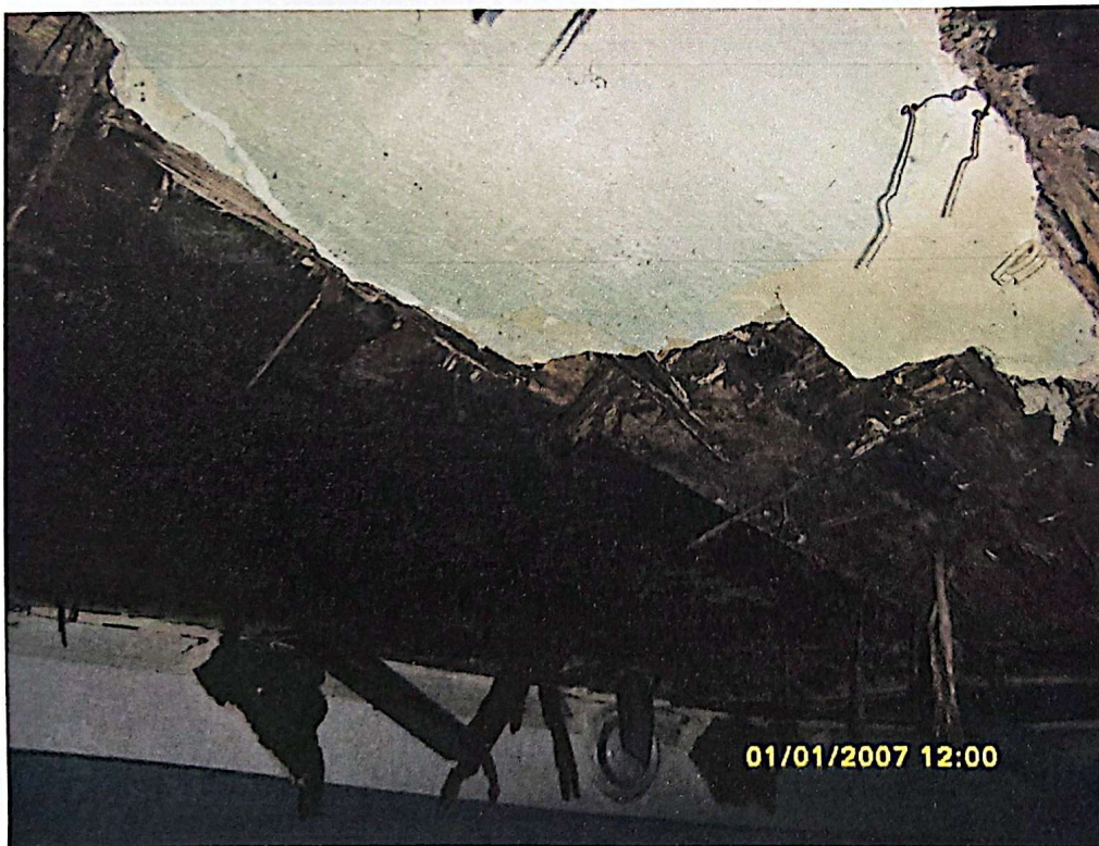
e: Anexa 8: Deformații structură planșeu peste subsol - Sector în limita volumului examinat.
