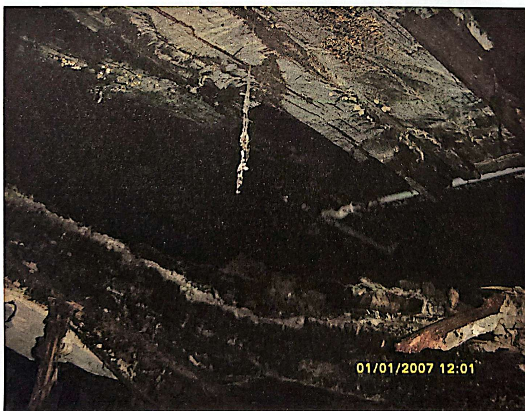
d: Anexa 8: Deformații structură planșeu peste subsol - Sector în limita volumului examinat.
