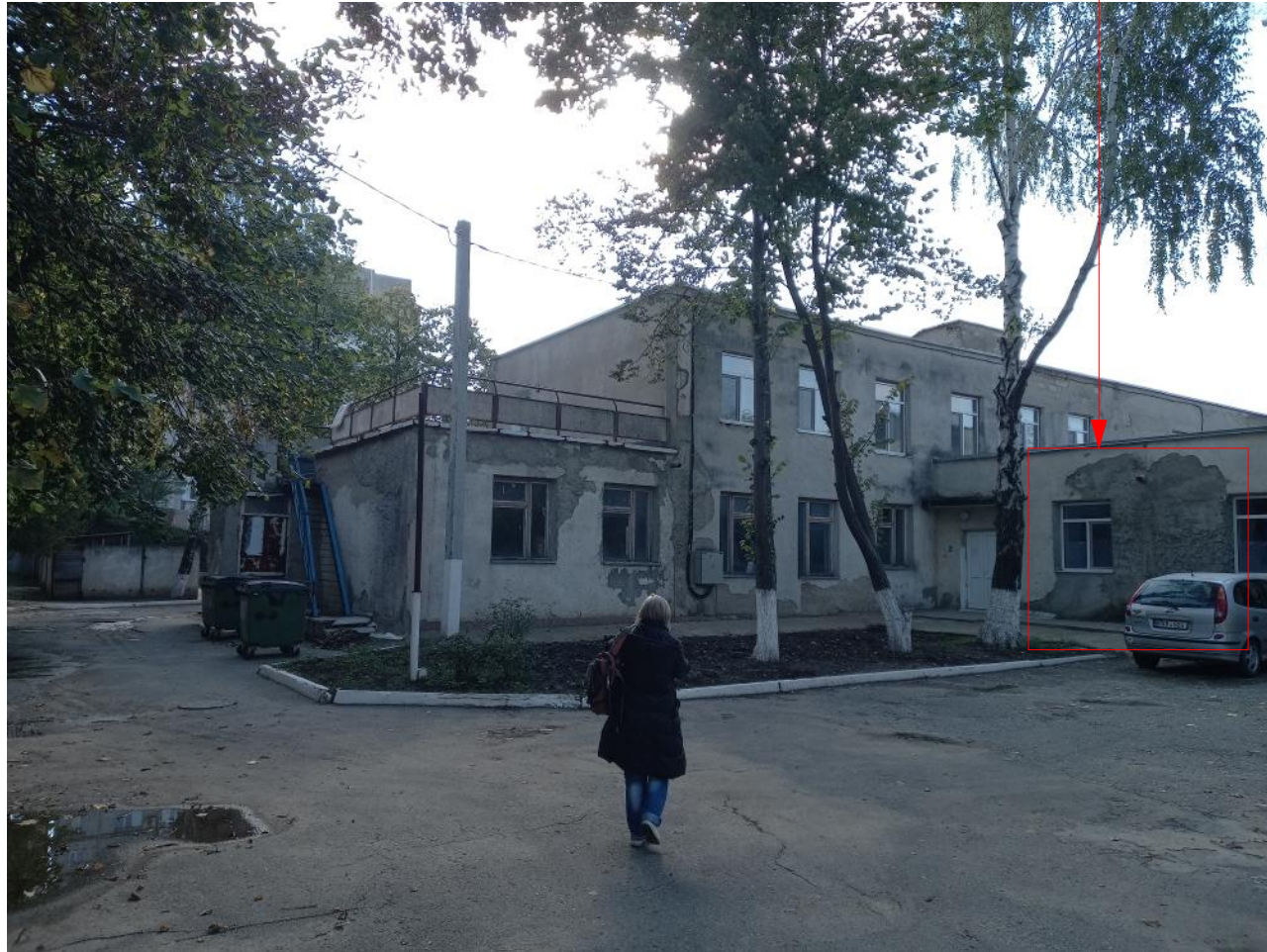
Tencială existentă distrusă - se demontează parțial
