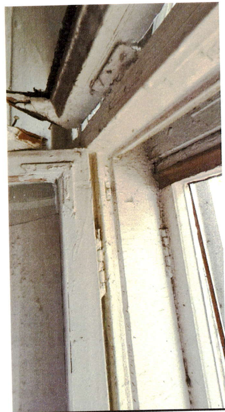
Sondajele de identificare a culorii originale a tamplariilor, prin decopertarea straturilor suprapuse de vopsea.
