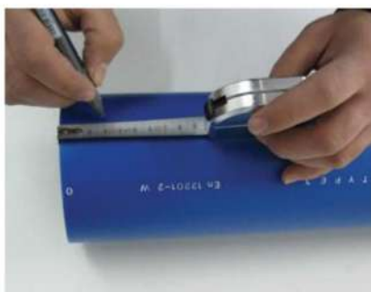
Măsurăți și marcați țeava
