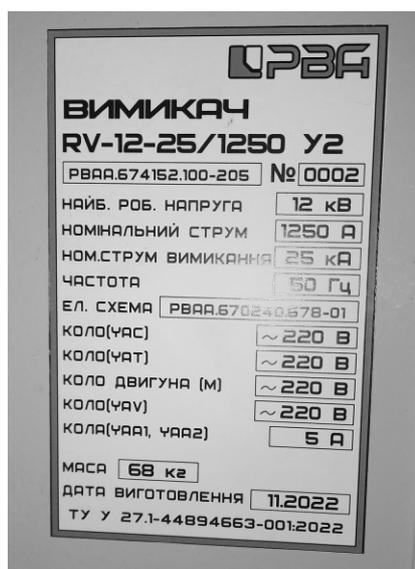
Рисунок 10.2 – Заводська табличка вимикача
