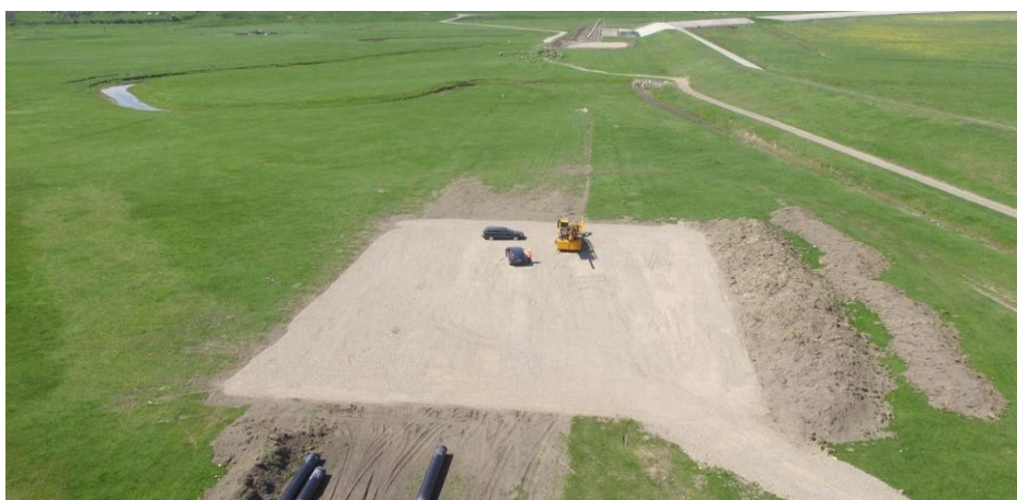
Exemplu de platforma de foraj dupa asternere strat de agregat
