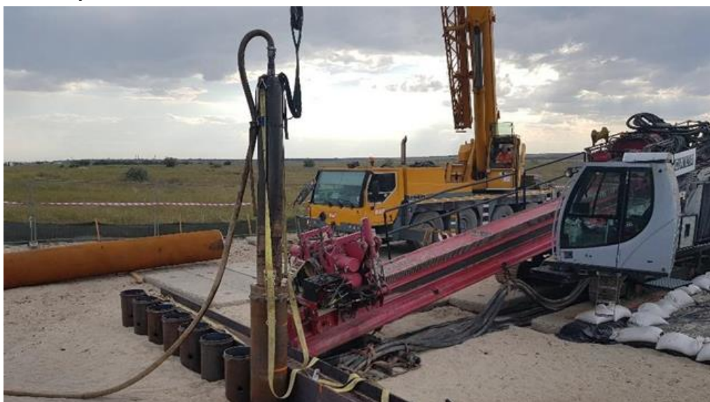
Testare sistem de foraj HDD
