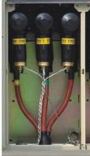
Рис. 14 Установка кабелей в кабельном отсеке
