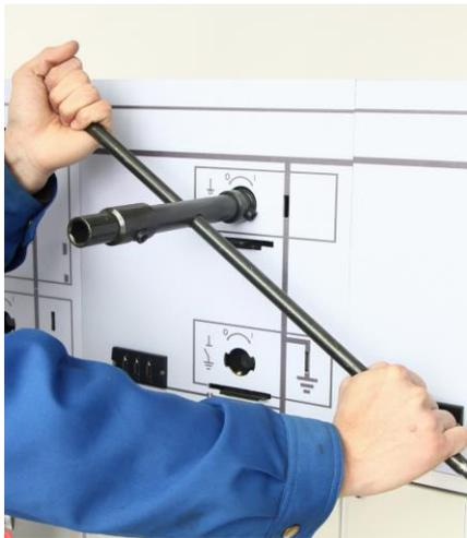
**Б) Ручное управление заземлителем**
