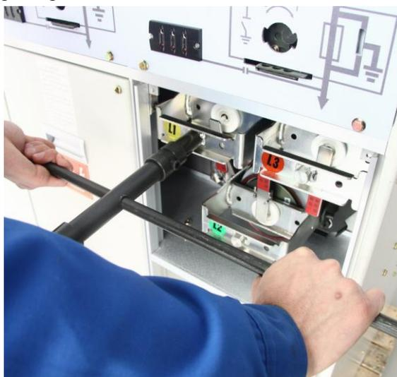
3.5.5 Снимите торцевую крышку изоляционного цилиндра предохранителя и установите конец предохранителя на торцевую крышку.
