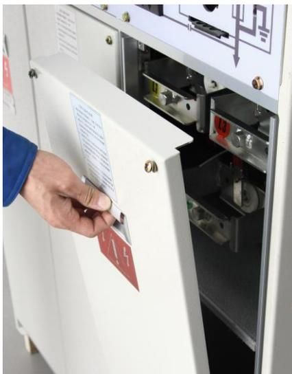
3.5.4 Поверните ручку управления против часовой стрелки, чтобы открыть торцевую крышку изоляционного цилиндра предохранителя.
