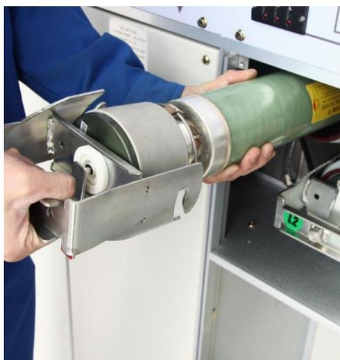
3.5.6 Закрепите предохранитель на торцевой крышке установки предохранителя крепежными винтами. Ударник должен указывать наружу, чтобы предохранитель мог нормально работать.
