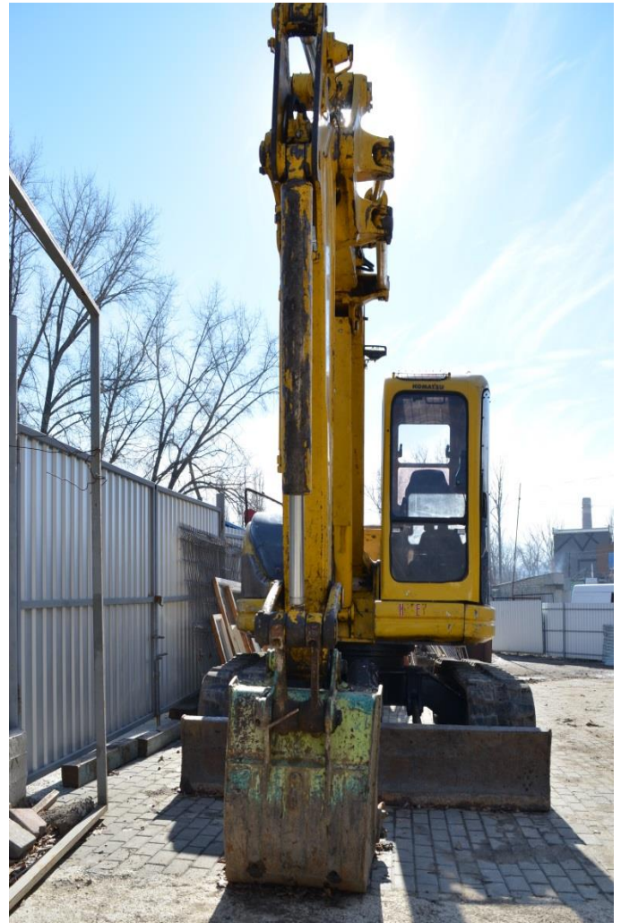
Figura 7. Vedere Nr.1 KOMATSU PC75UU-2
