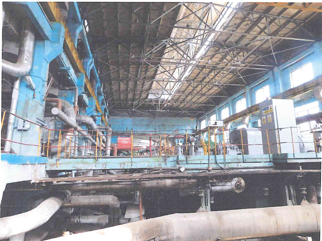
d : Anexa 3: Clădirea principală de producere cu nr. cadastral 0100424.045.51, în limita căreia se află volumul examinat, din cadrul CET –1 (Sursa 2) de pe str. Vadul lui Vodă, nr.5, mun. Chișinău.
