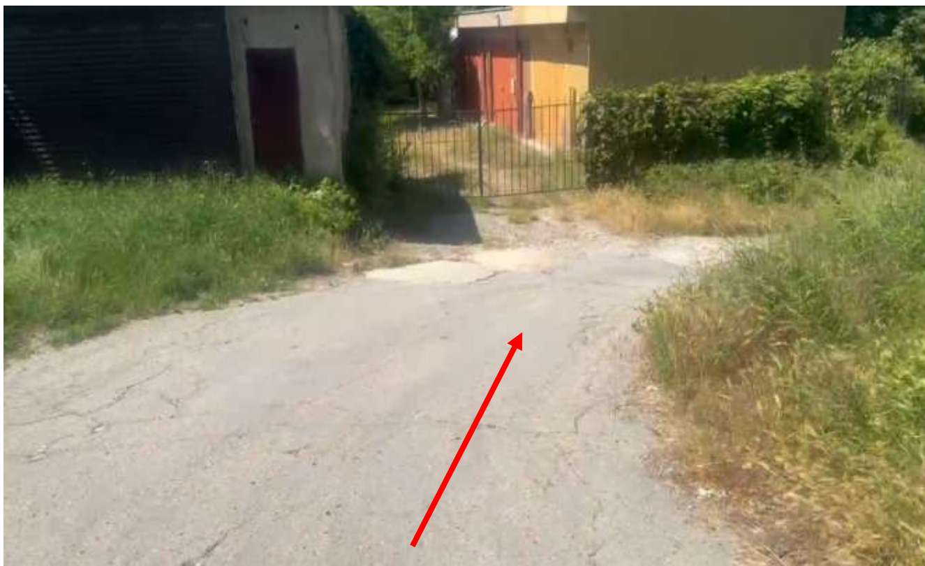
Fig. 1.8 Situație existentă PC 0+05. (Acces)
