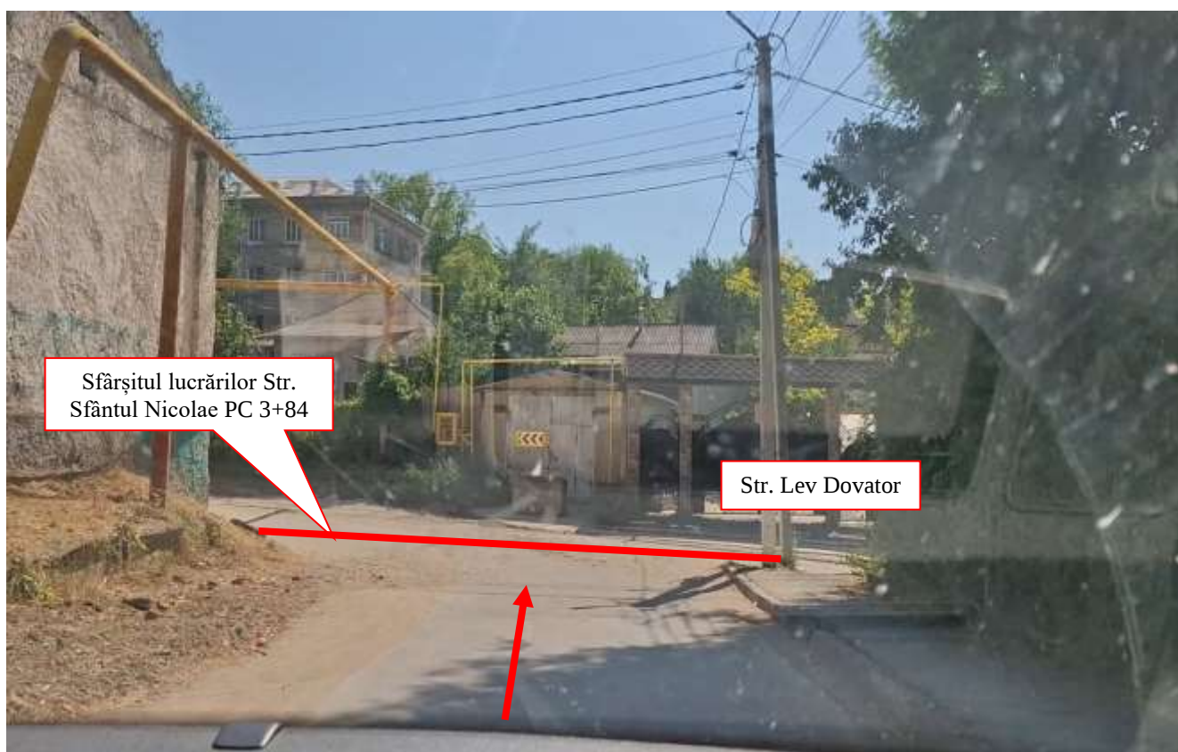
Fig. 1.7 Situație existentă PC 3+80. (Str. Sfântul Nicolae)
