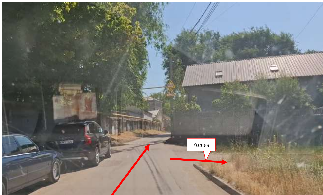
Fig. 1.6 Situație existentă PC 2+80. (Str. Sfântul Nicolae)
