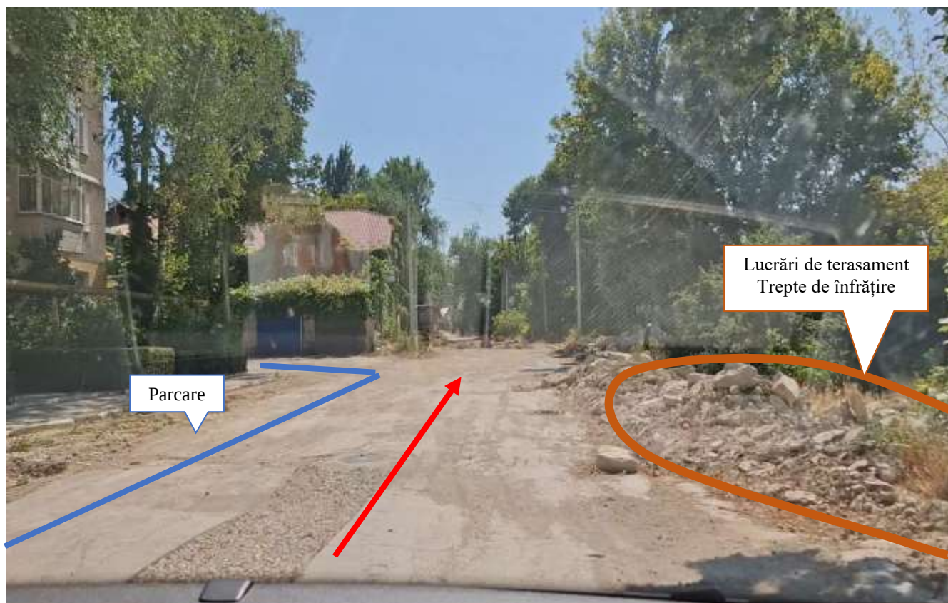
Fig. 1.4 Situație existentă PC 1+30. (Str. Sfântul Nicolae)
