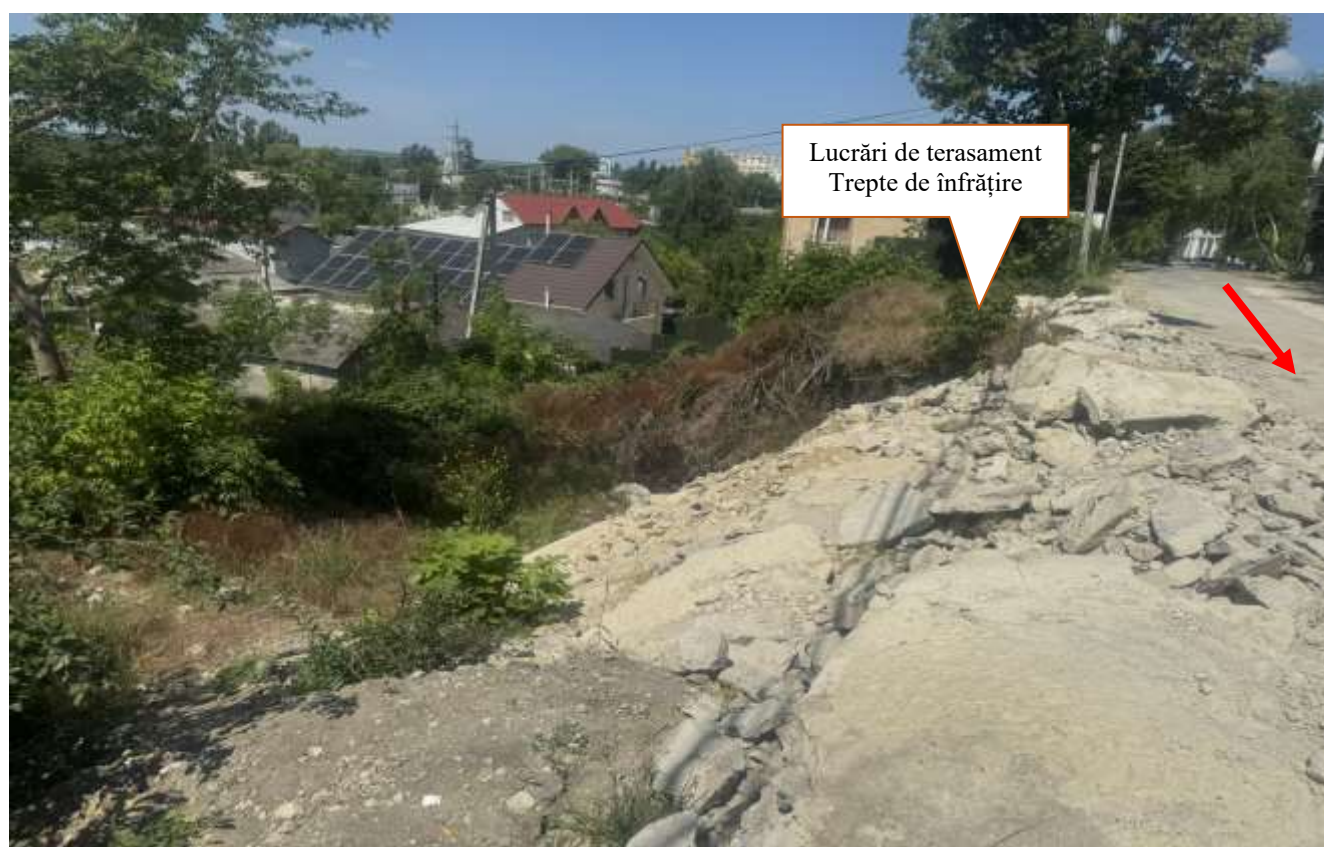
Fig. 1.5 Situație existentă PC 1+50. (Str. Sfântul Nicolae)
