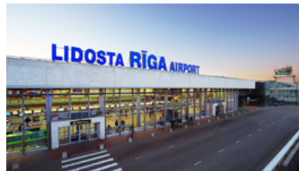
РЕКОНСТРУКЦІЯ: АЕРОПОРТ М. РИГА JAUDA Рига, Латвія 2019
