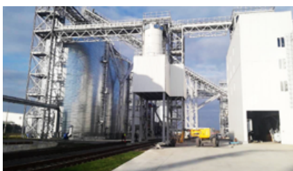
РЕКОНСТРУКЦІЯ: СУШИЛЬНИЙ ЦЕХ ООО «УХЛК» Житомирська обл. 2018
