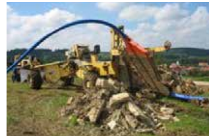
așezare fără săpatul șanțului deschis metoda așezării prin arat
