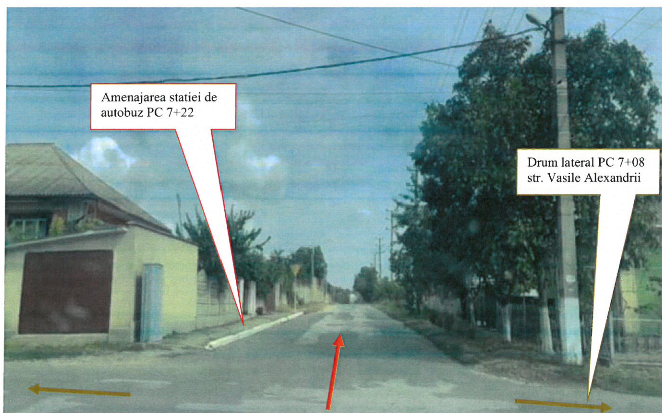
Fig. 1.7 Situație existentă PC 7+10 (str. Alexandru cel Bun)
