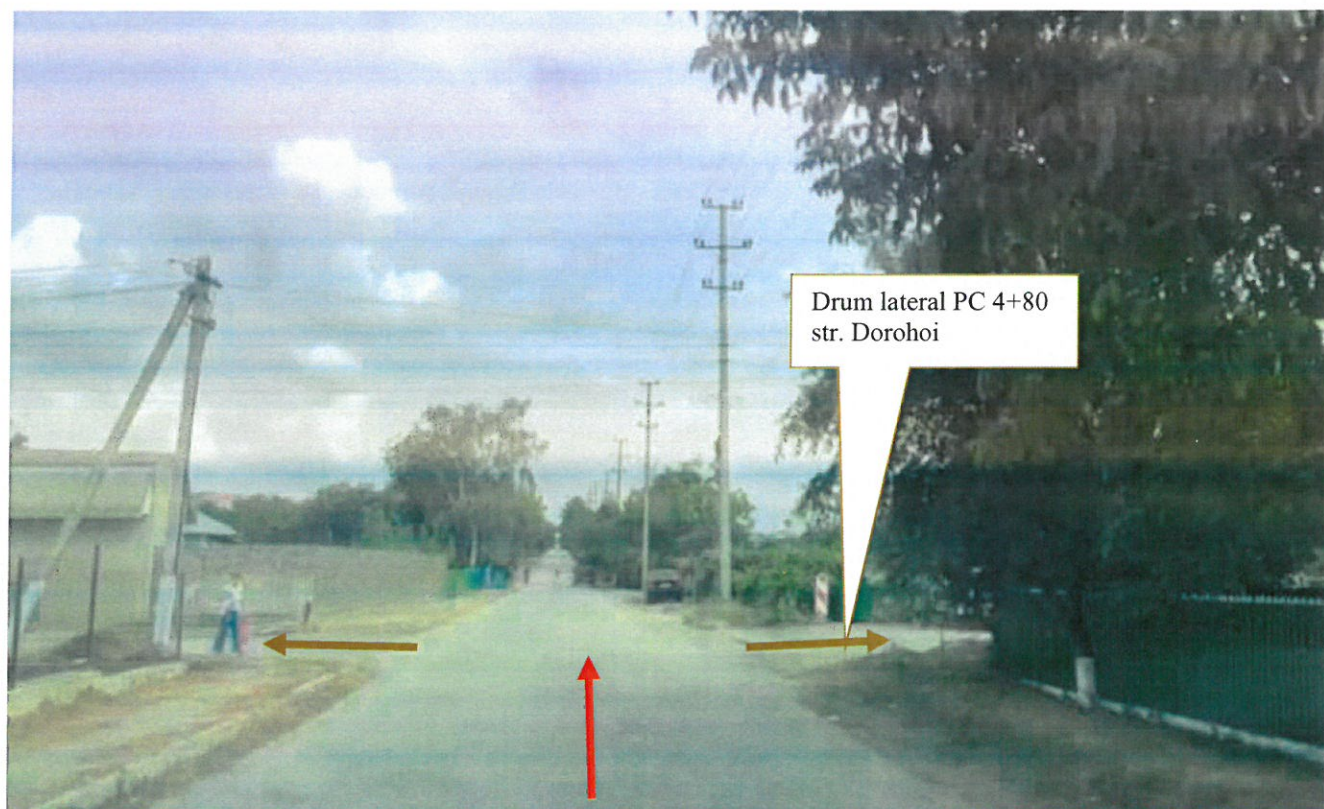
Fig. 1.6 Situație existentă PC 4+70 (str. Alexandru cel Bun)
