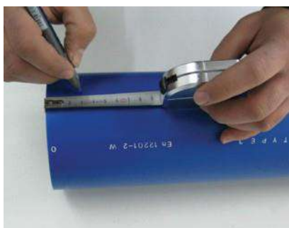
Măsurați și marcați țeava
