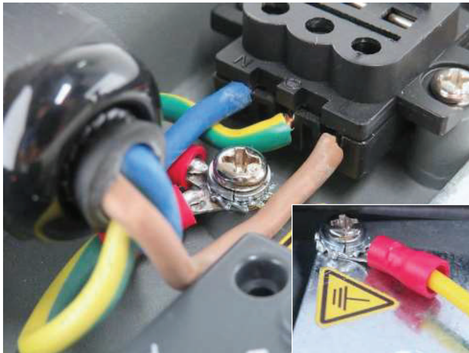
M60W36L505057CRI70KHP10D6I60TDD2CLI puncte de împământare
