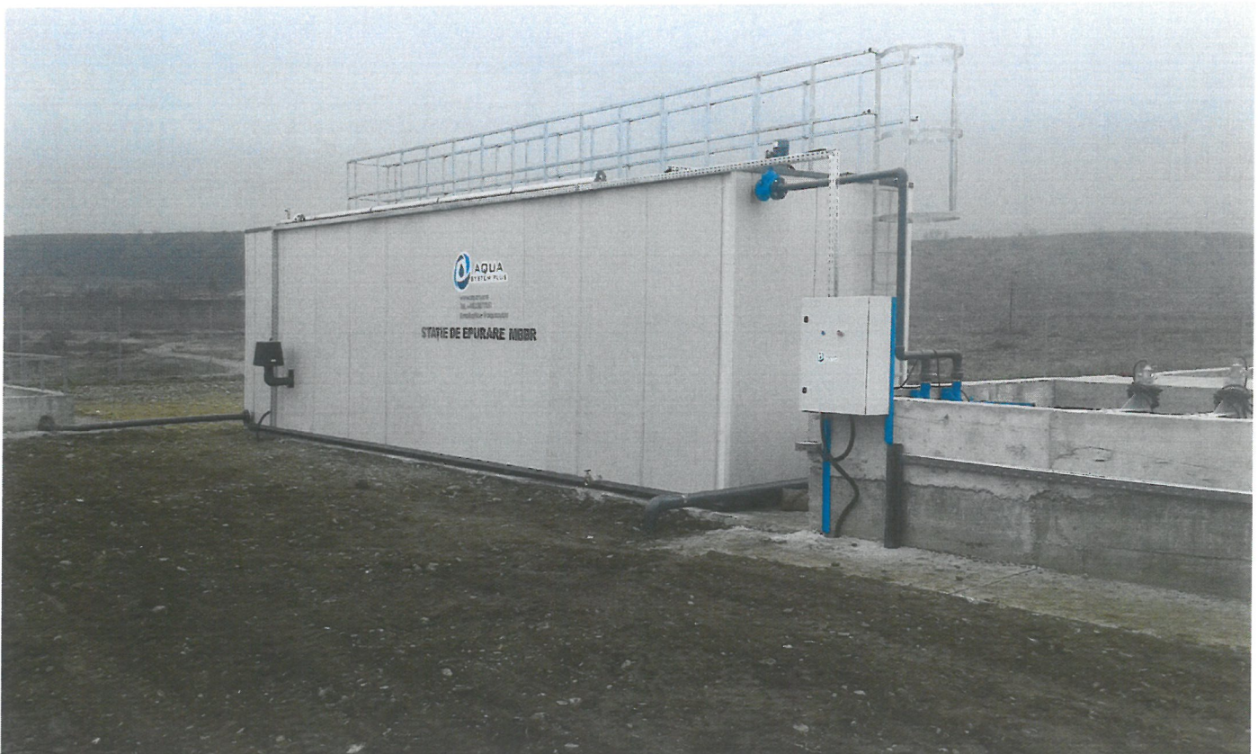
STAȚIE DE EPURARE TIP MBBR
