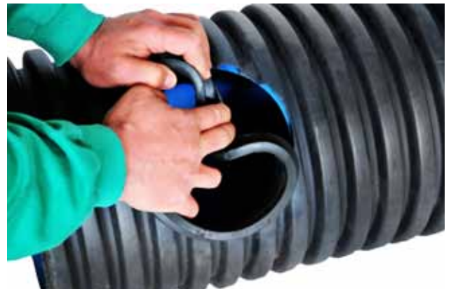
4. Se poziționează conectorul lateral
