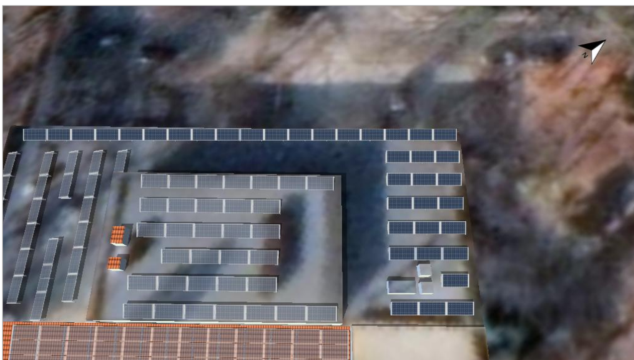
Figura: 4. Zona modulului - Spalatoria -Mounting Surface Northwest
