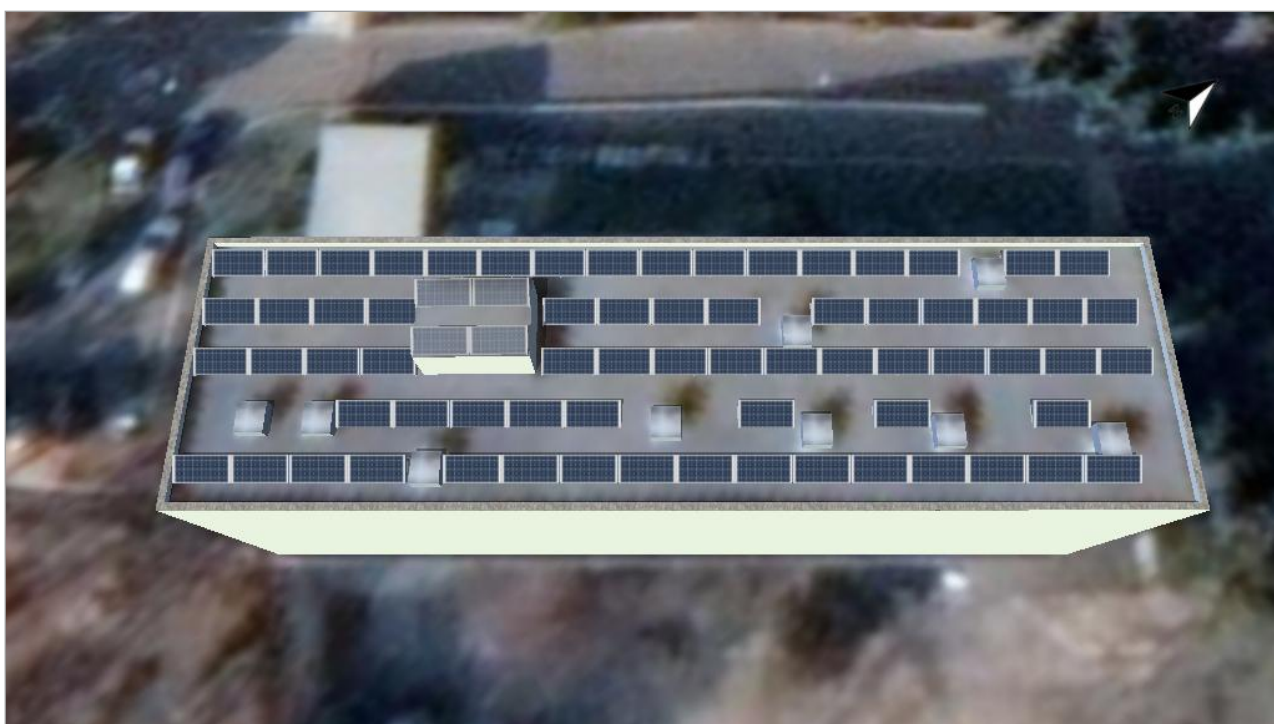
Figura: 11. Zona modulului - Blocul morfopatologic - Mounting Surface Northwest
