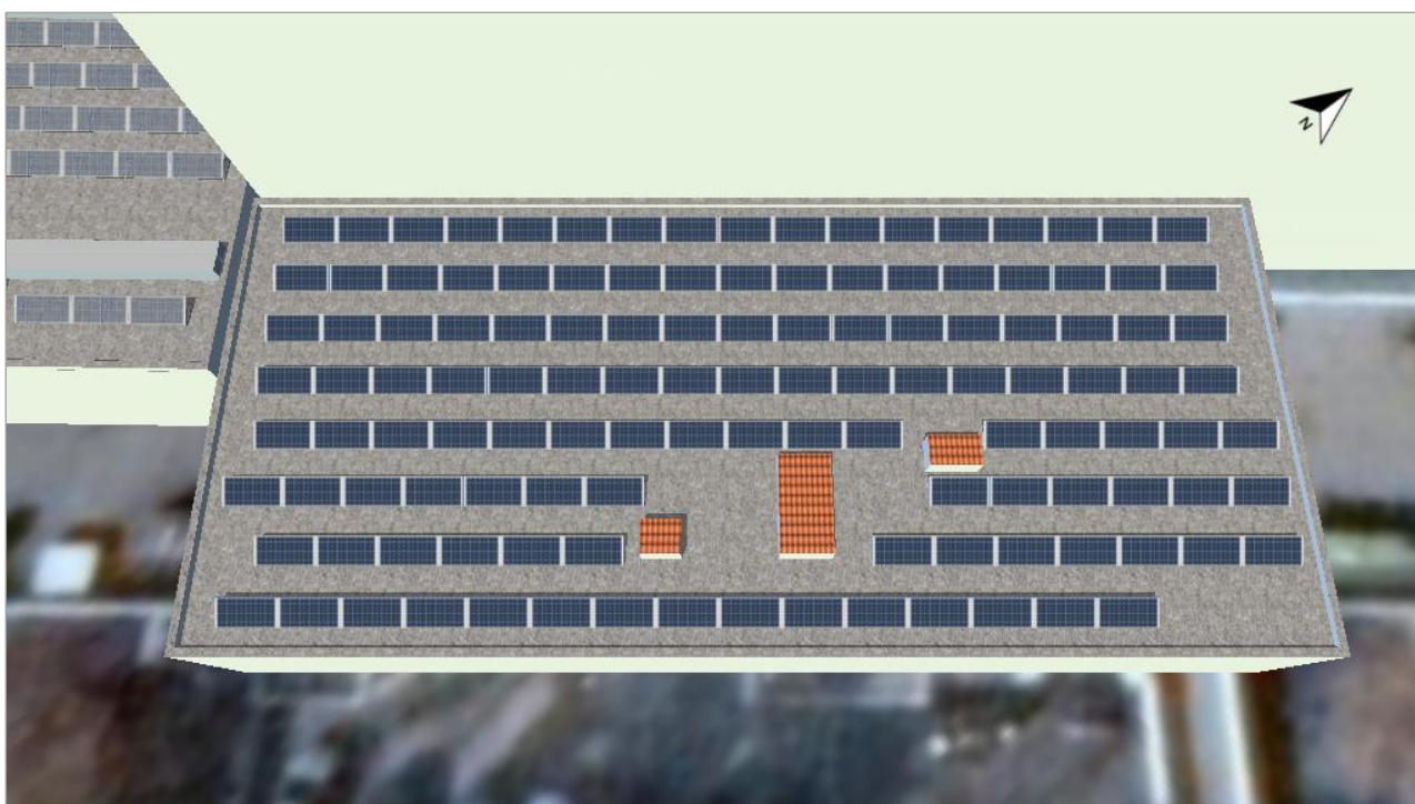
Figura: 7. Zona modulului - Blocul Medicinal-Roof Area Southeast
