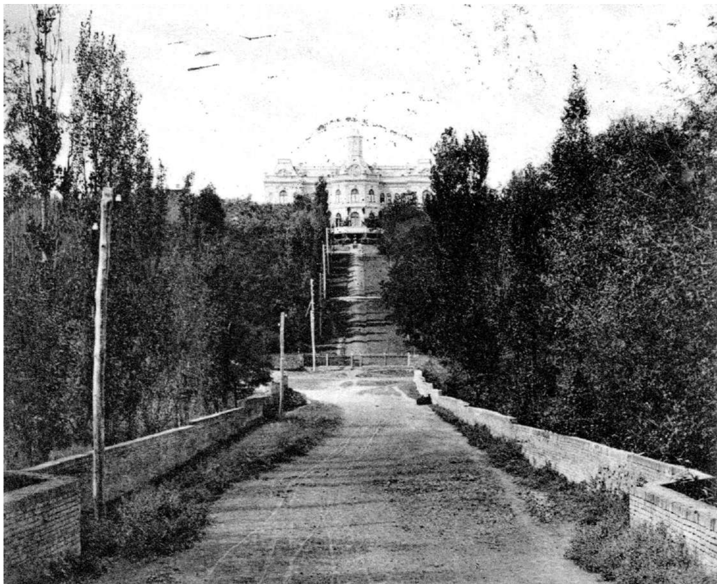
Fig. 2. Fotofixare Scară acces către Complex
