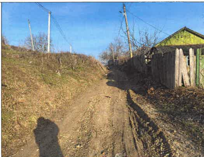
PC1'+00, Poza este executată spre sfirsitul traseului.
