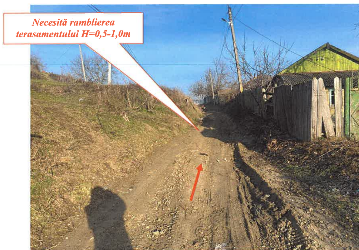
Foto.9. Situatia existanta la drum lateral la PC1'+00
