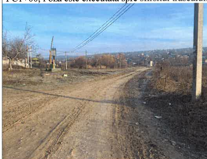
PC2+50, Poza este executată spre începutul traseului.
