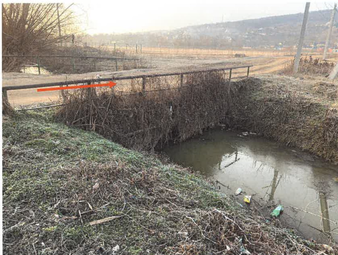
Foto.3. Podet existent la PC0+65 în albia râulețului Ișnovăți (în amonte)
