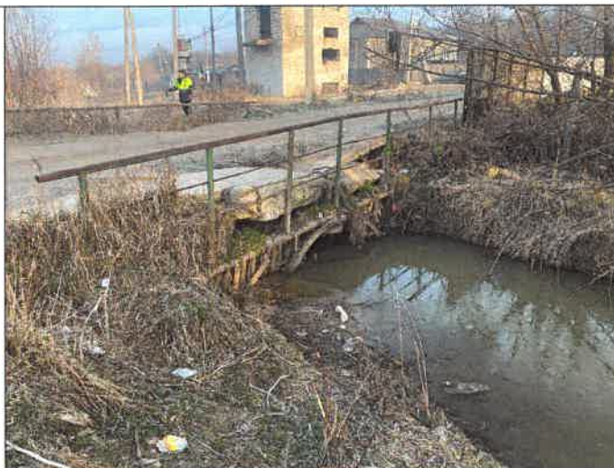
PC0+65, Pod existent (în aval).
