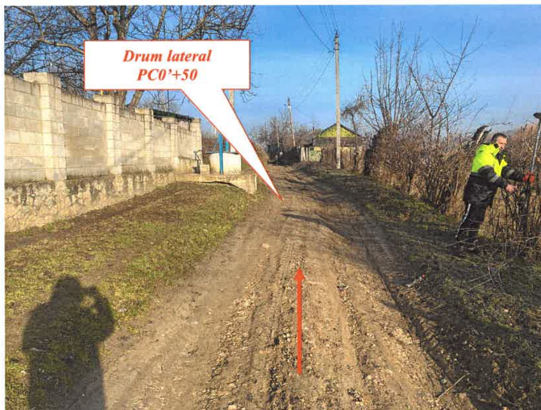
Foto.8. Situatia existanta la drum lateral la PC0'+50.
