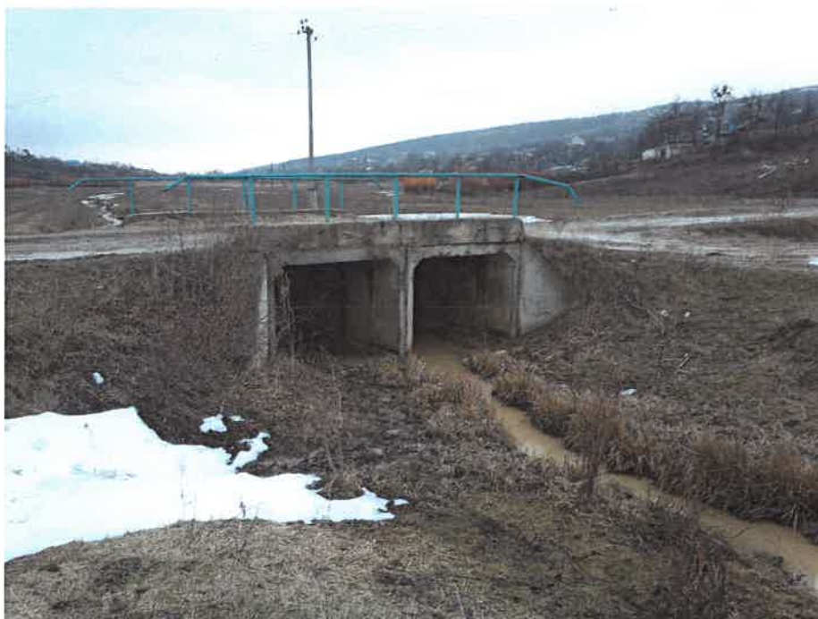
Poza 11. Podet existent la distanța 1,5km de la podul proiectat (în amonte)
