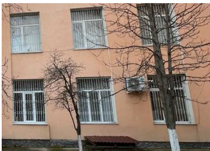
Figura 20. Vedere a condiționerului
