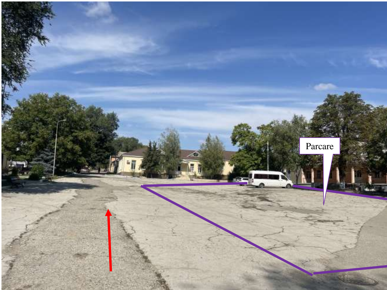
Fig. 1.3 Situația existentă PC 0+10
