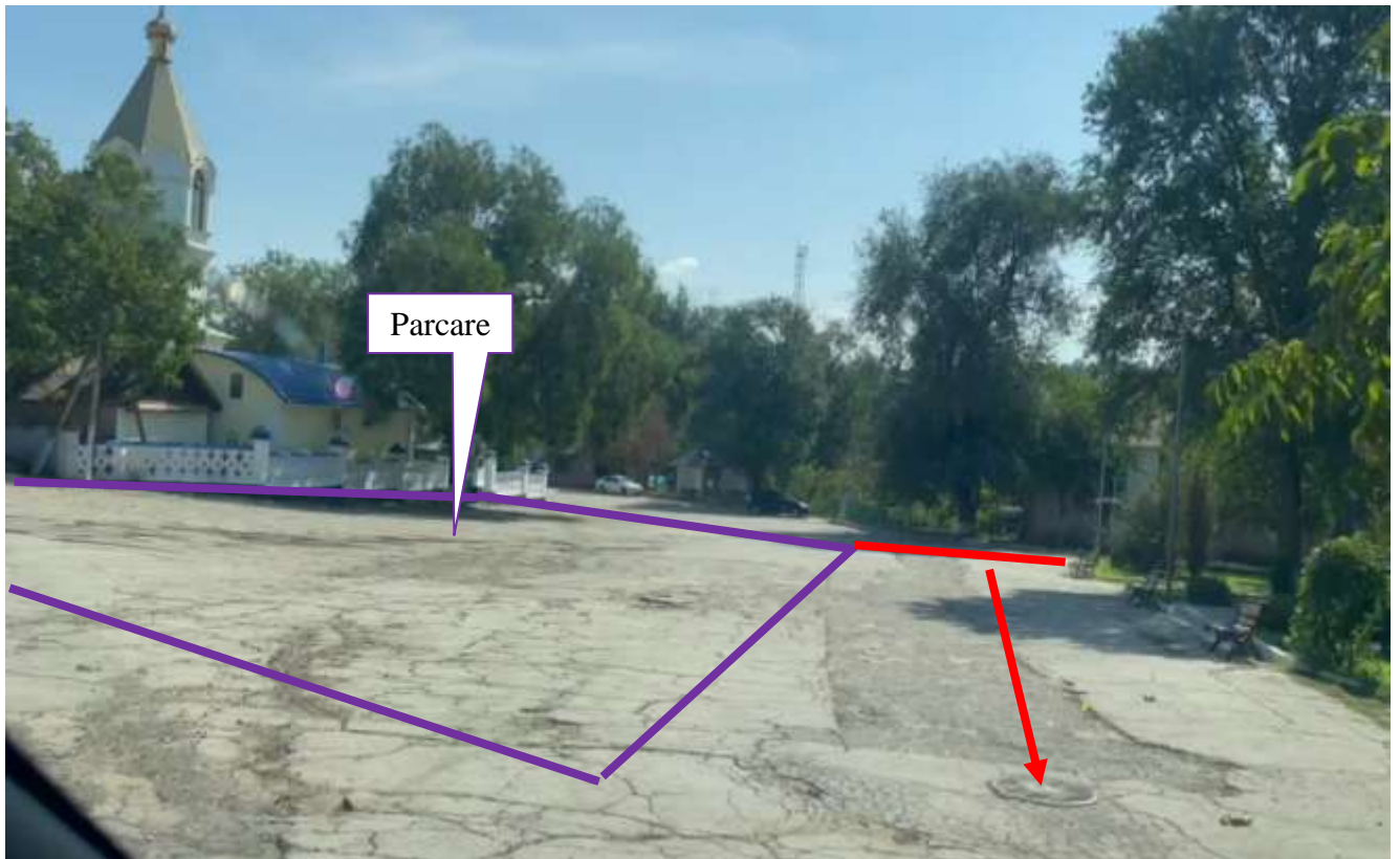
Fig. 1.5 Situația existentă PC 0+65
