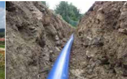
așezarea fără patul de nisip
