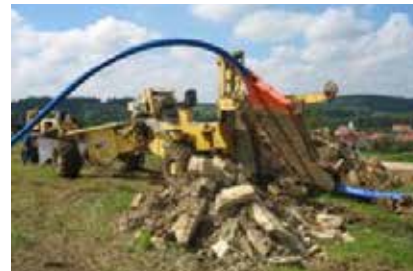
așezare fără săpatul șanțului deschis metoda așezării prin arat
