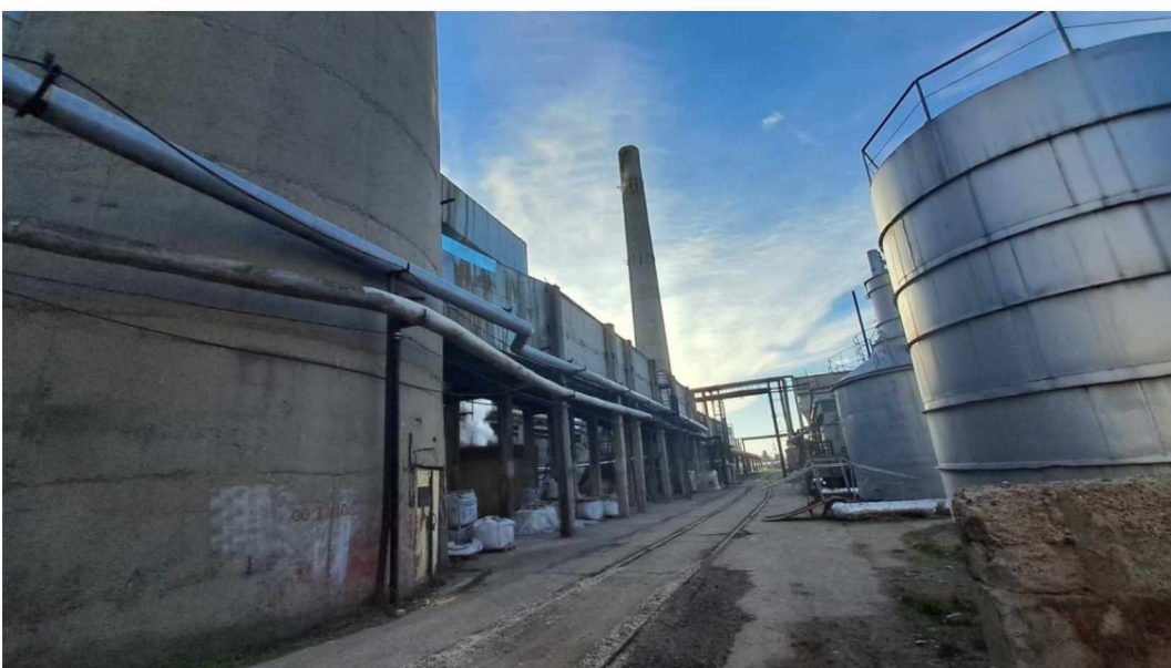
Foto nr. 4; 5; 6. Vederi generale ale construcției examinate.
