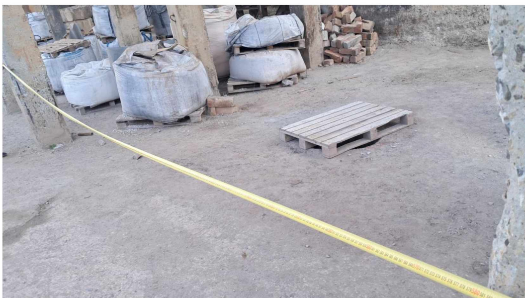
Foto nr. 10; 11; 12. Măsurări.
