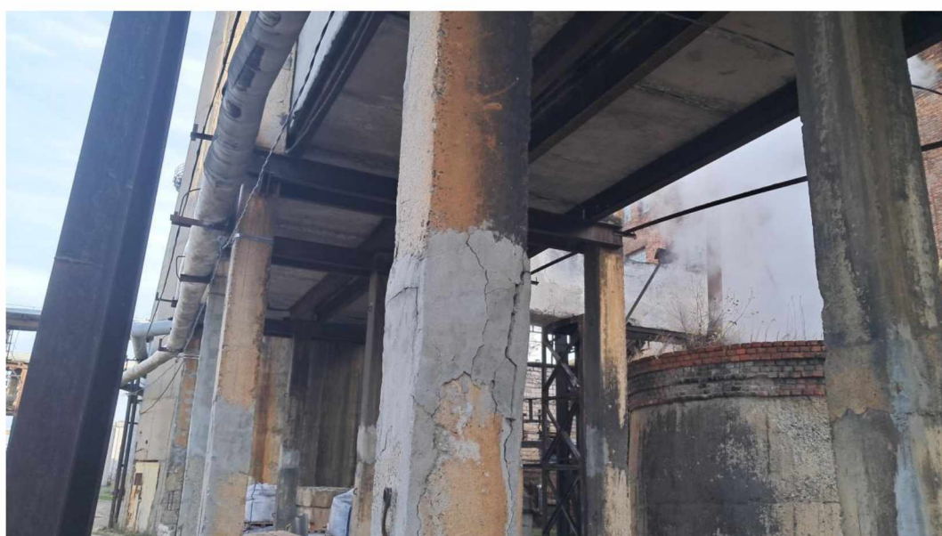
Foto nr. 17; 18. Vederi generale ale pilonilor canalului.
