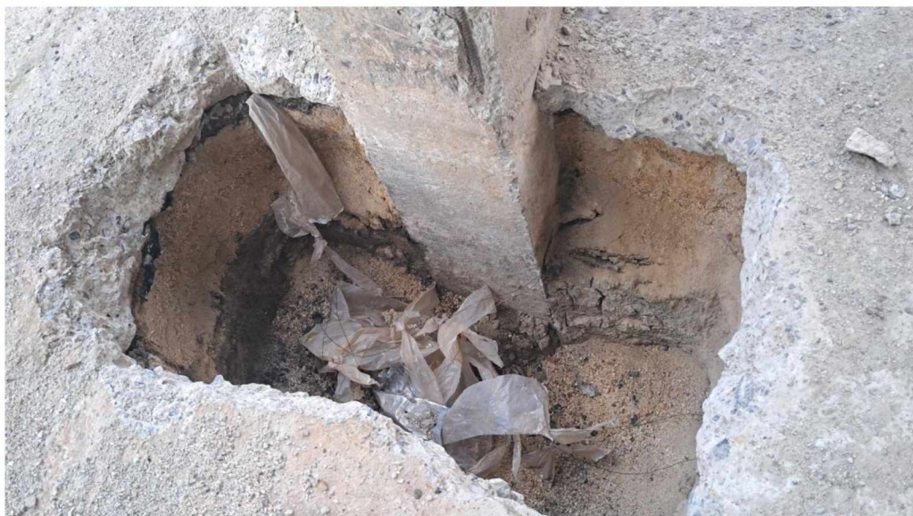
Foto nr. 16. Starea tehnică a pilonilor mai jos de cota planificată a terenului.
