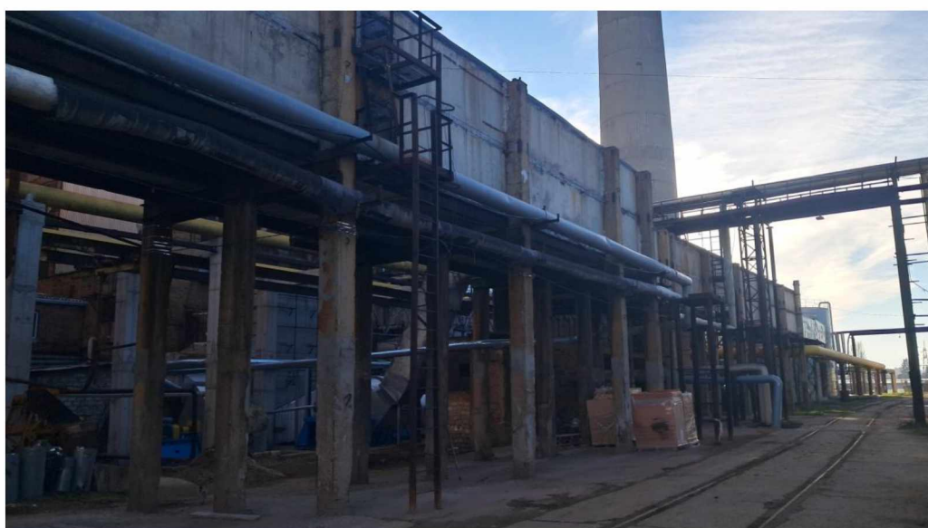
Foto nr. 1; 2; 3. Vederi generale ale construcției examinate.
