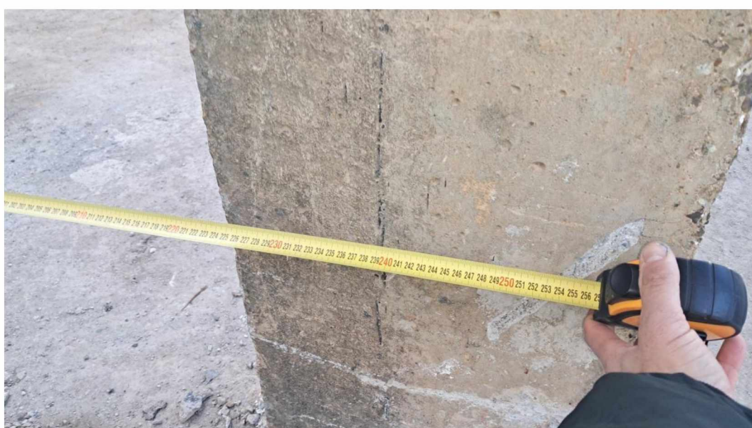
Foto nr. 13; 14; 15. Măsurări.
