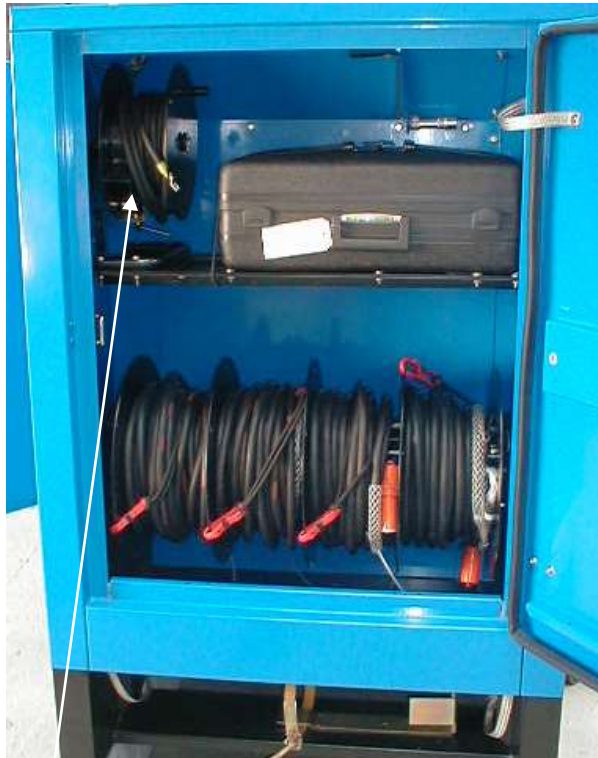
Figure 7 - Câble de terre
