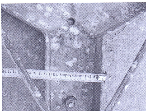
Fundația sub turn și dimensiunile geometrice ale fundației și elementelor tălpii turnului
