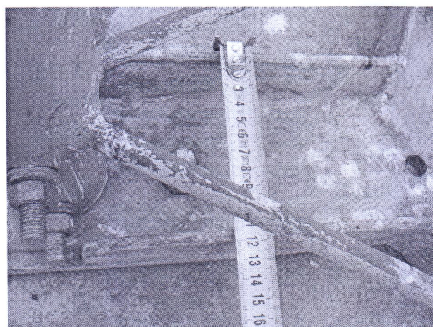
Fundația sub turn și dimensiunile geometrice ale fundației și elementelor tălpii turnului
