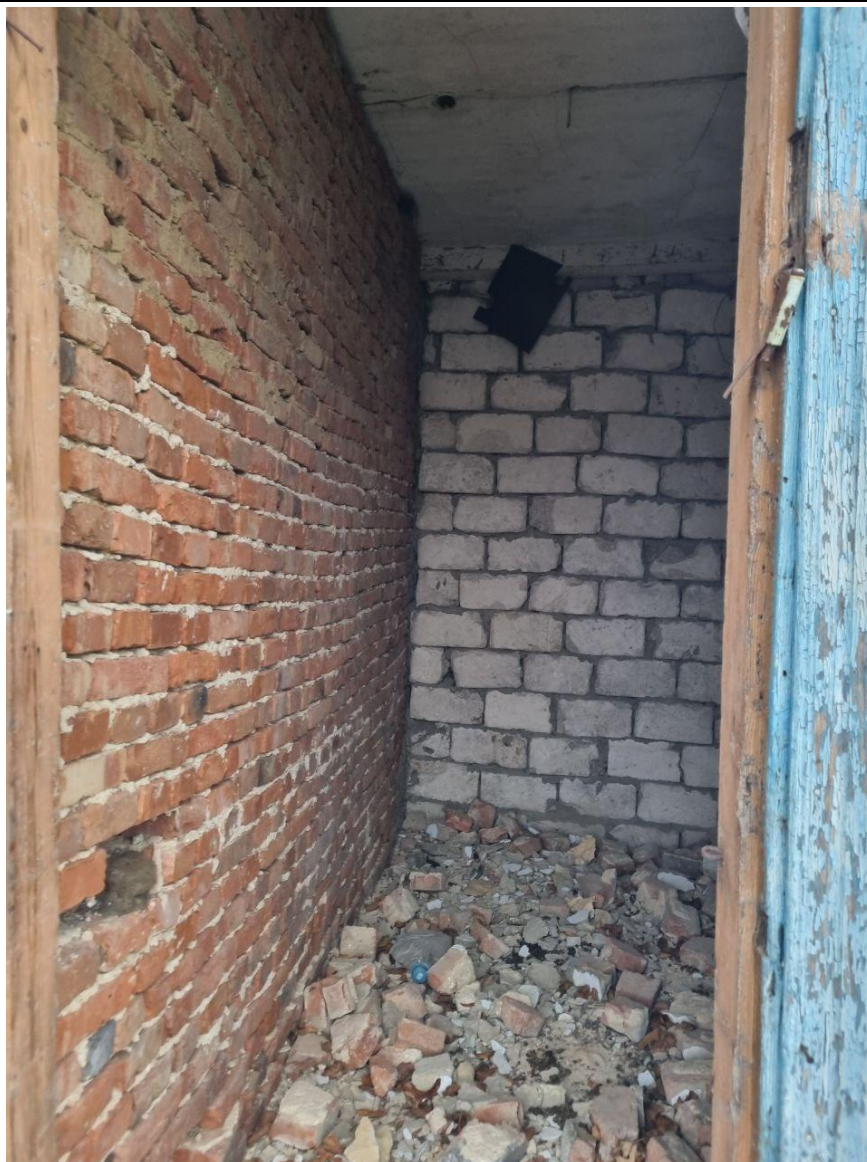
Figura 2-11. Construcția nr. 1 (interior)
