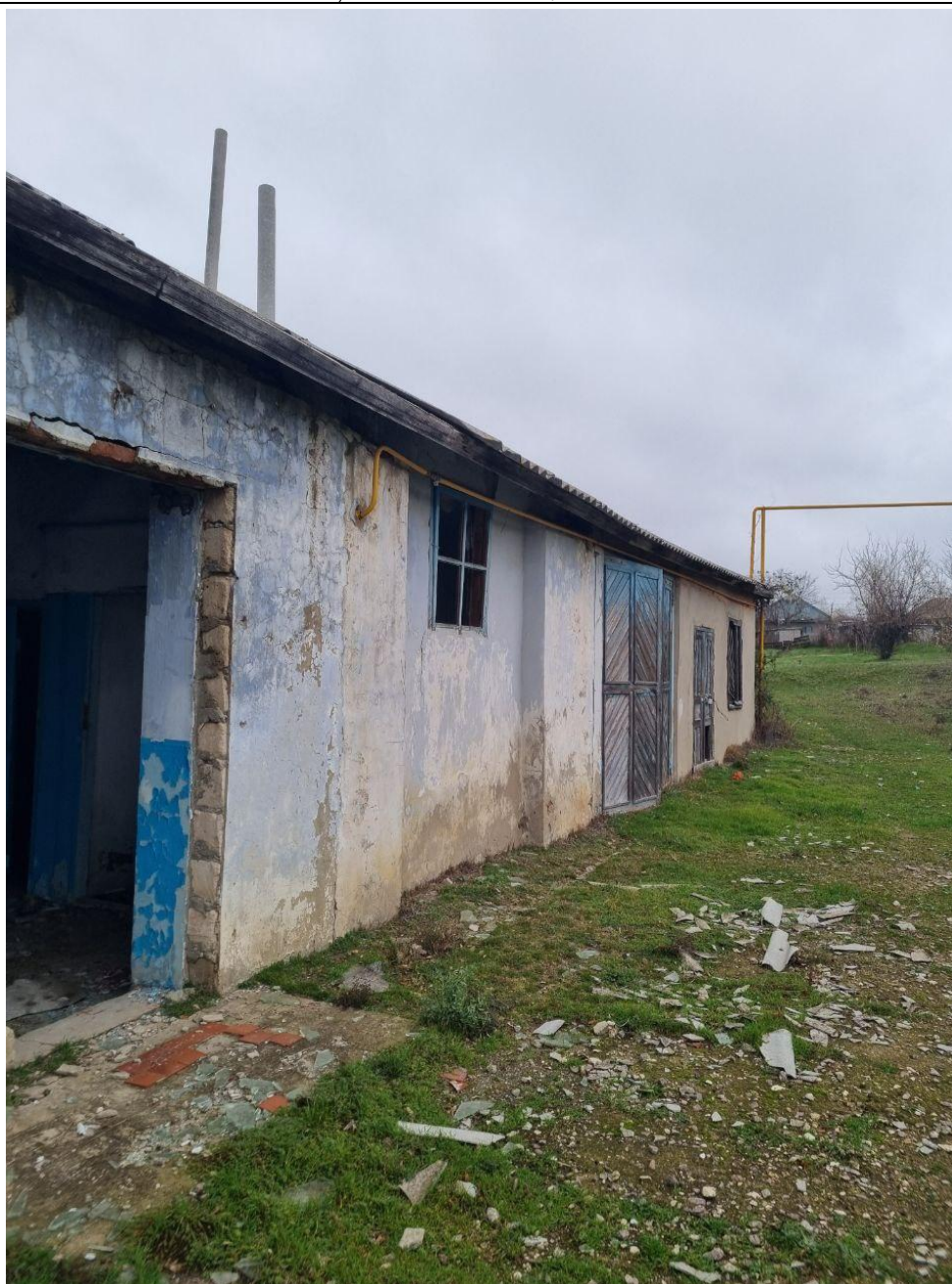
Figura 2-7. Construcția nr. 1 (intrarea secundară)
