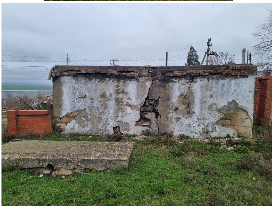
Figura 2-9. Construcția nr. 3 (construcție accesorie)
