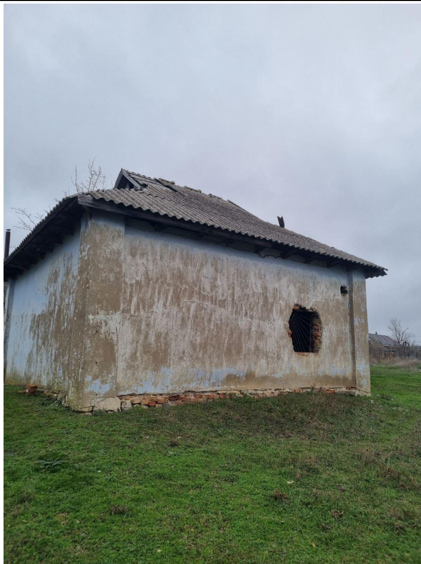
Figura 2-8. Construcția nr. 2 (construcție accesorie)
