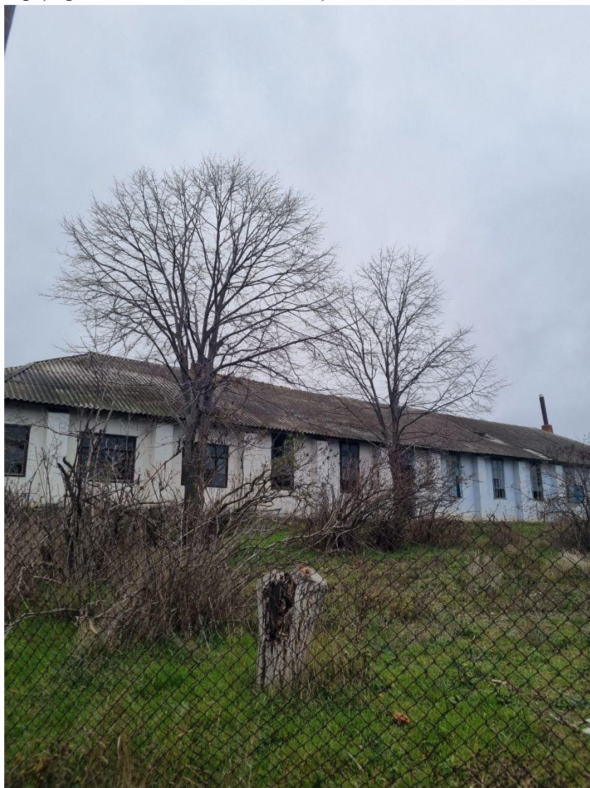
Figura 2-5. Construcția nr. 1 (vedere din față)
