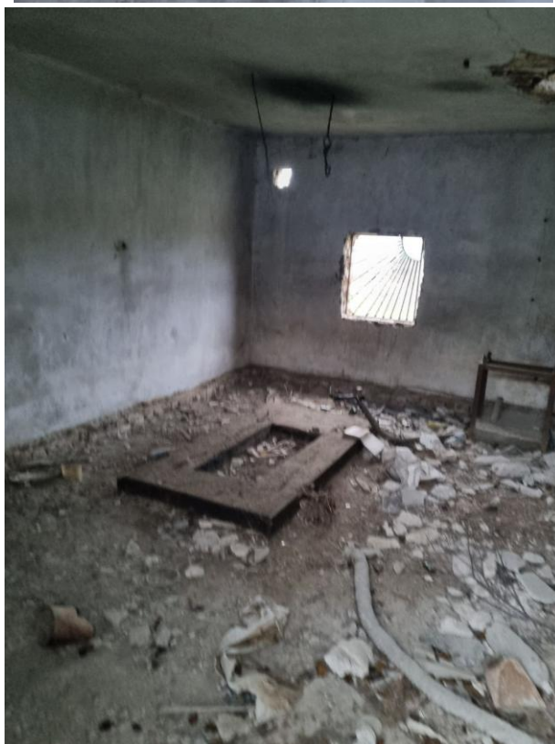
Figura 2-10. Construcția nr. 2 (tavan)
