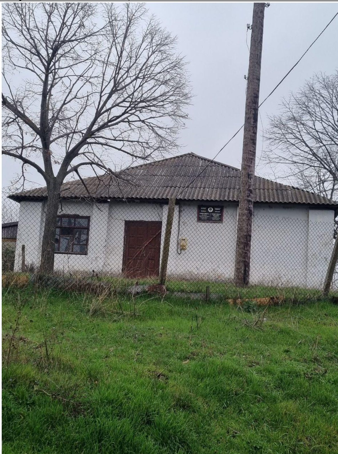
Figura 2-6. Construcția nr. 1 (vedere laterală)
