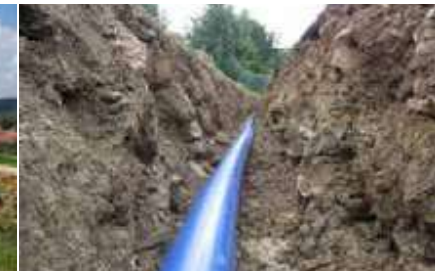
așezarea fără patul de nisip
