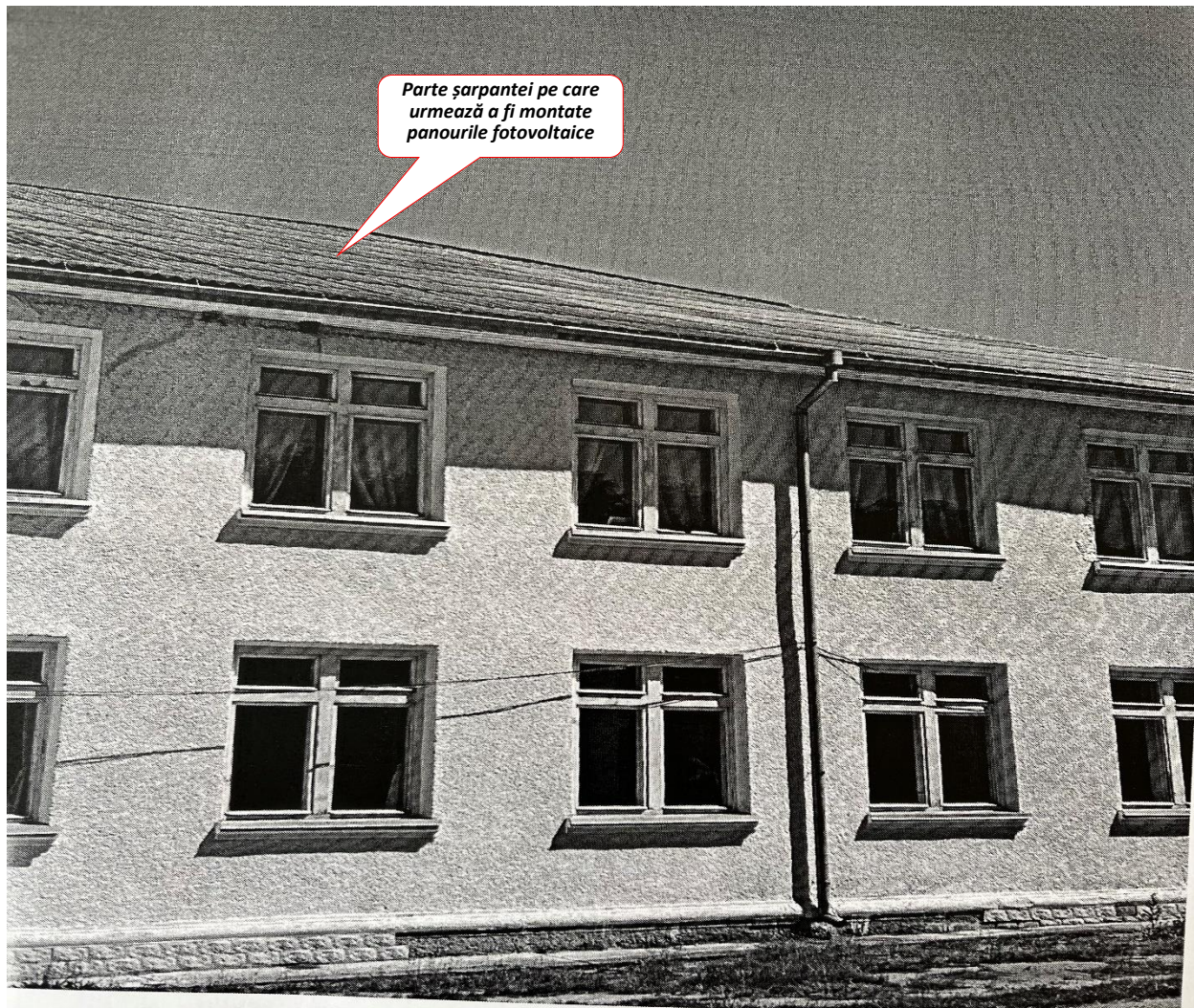
Fotofixare 1 (Aspectul clădirii examinate)
